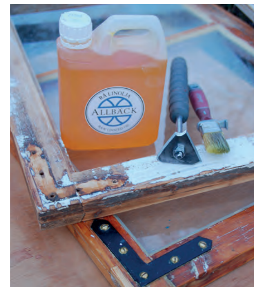
Eksempel på ramme med og uten hjørnejern. Foto: Håkon Gøthesen
