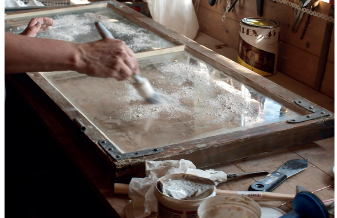
Fordel krittet på glasset med en pensel for å fjerne fett. Foto: Gamletrhus.no v/Roger Falldalen
