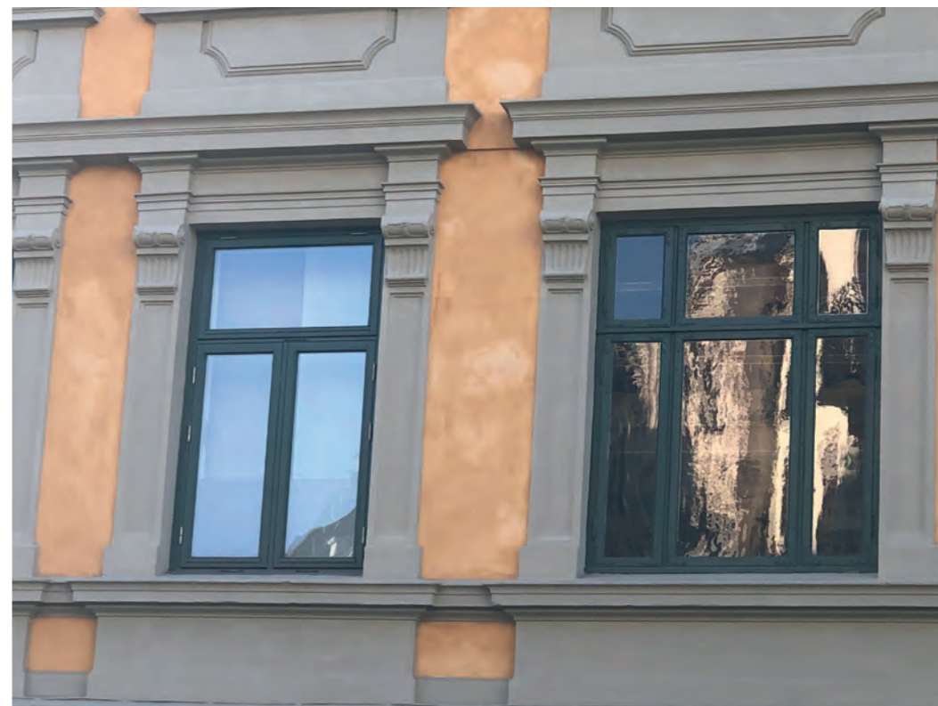
Nytt og gammelt glass. Her ser man hvordan utskiftning kan få store konsekvenser for hele fasadeuttrykket. Gamle glass har et helt annet spill i lysrefleksjonene. Nytt glass er helt flatt. Foto: Gunnhild Ryen / Kulturminnefondet.
