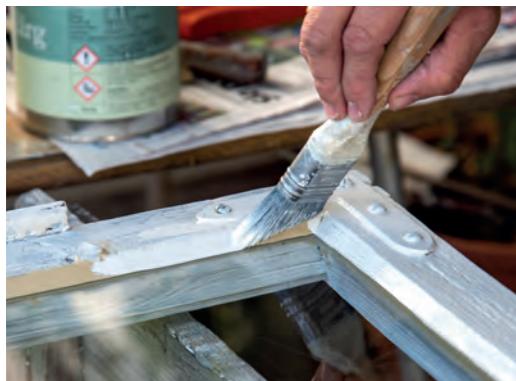
Kitt, glass og beslag males over. Foto: Tor Harald Frøyset / Magasinet Norske Hjem
