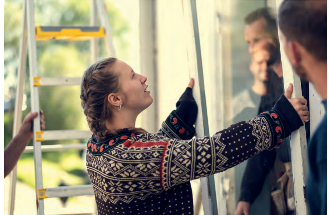
Husk å merke alle vinduene du skal ta ut med maskeringstape før du tar de ut. Foto: Bård Gundersen / Fortidsminneforeningen
