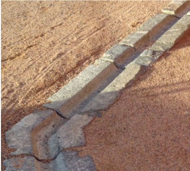
En rännal i hel sten (bilden till vänster) är kostsam att anlägga, men kräver relativt lite underhåll och skötsel och har mycket lång livslängd. En rännal i kullersten (bilden till höger) kostar mindre att anlägga, men kräver mer underhåll och skötsel och har betydligt kortare livslängd. Foto: Joakim Seiler (vänster), Tina Westerlund (höger).
