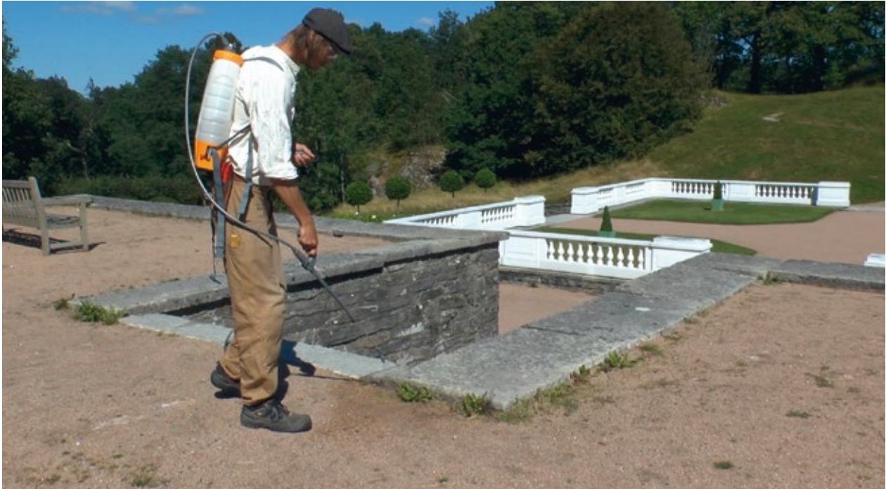
Bekämpning med ättika skall alltid utföras med skyddsglasögon och vid vindstilla förhållanden. Ättikan kan appliceras med ryggspruta vilket har till fördel att man kommer åt på otillgängliga ytor. Nackdelen är att aggregatet är tungt att bära på i längden. Foto: Tina Westerlund.
