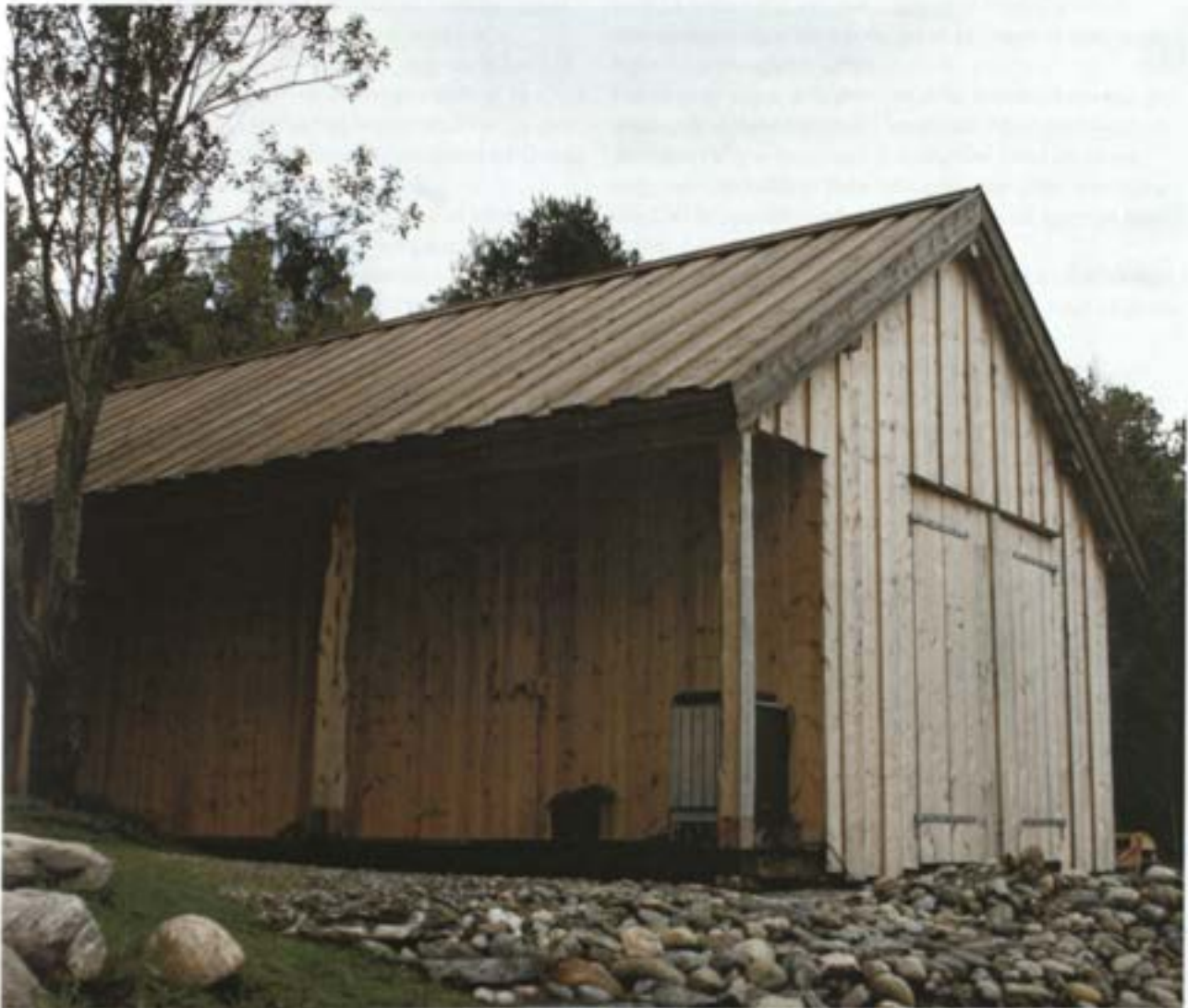
Ferdig bygg. (Byggherren har selv stått for teking og kløring)
