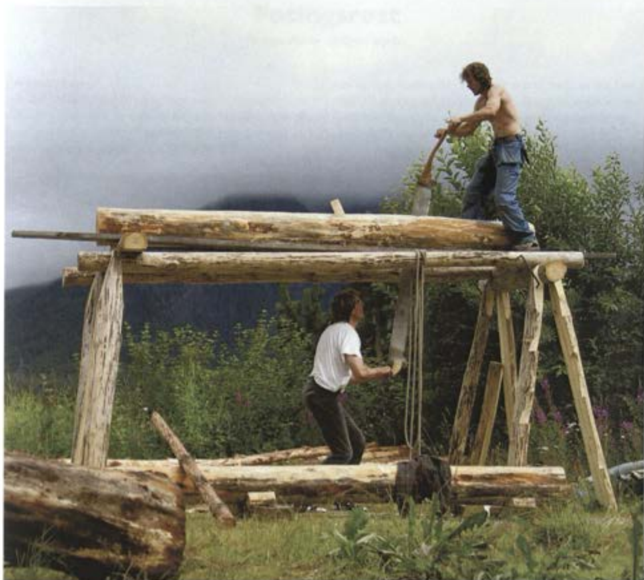
Håndsag skjering av skråband Thomas Aslakby øverst på sagstillingen.
