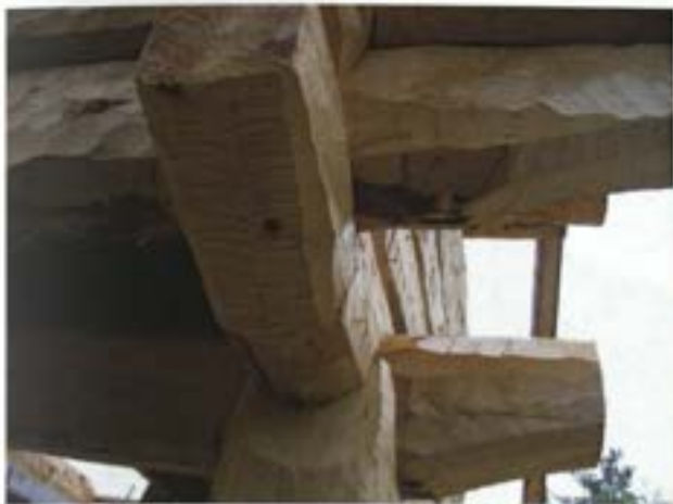
Pyrteprofiler på stokkendet hugd med gleppåke.
