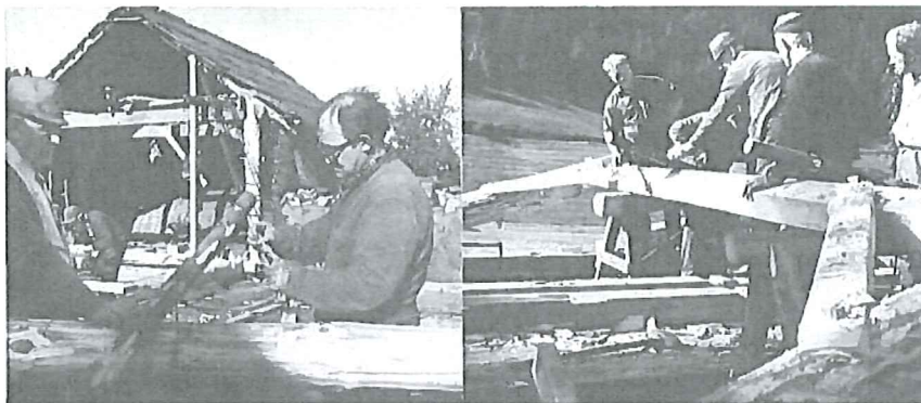
Over til venstre: Kåre Hartveit trær tauet gjennom hepingastonga og lagar lykkje på tauet. — Til høgre: Dei fester hepingastengene til beten med å leggja tauet kring beten og smetta lykkja inn på enden av stonga. — Under: To mann pressar på med hepingastenger. Andre lyfter utan reiskap.
