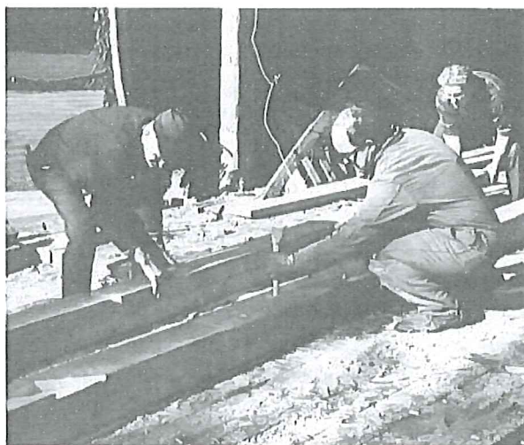
Dei slår naglane gjennom skøyten i stavlæggja. Stillsbileta vart tekne av forf.
