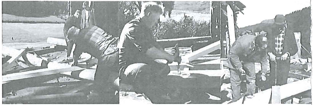
Til venstre: Klemhakar held stavane fast til stavlægjene medan dei merker opp for snedbønda. — I midten: Jon Myking gjer innhakk i stavlægja der eit snedband skal fellast inn. — Til høgre: Når snedbønda er felle inn, borar dei hol for naglar, her i staven. Fremst til venstre ser ein klemhakar som held staven fast til stavlægja.
