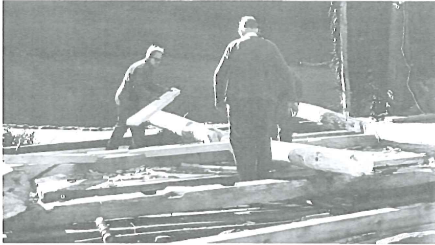
Alle snedbønd i lengderetninga vert slegne lause og lagde til sides.
