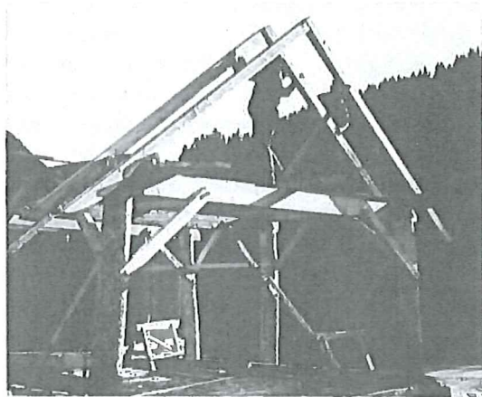
To sperrepar er komne på plass. — Til høgre hopfellingsmåtar med sperrer.
