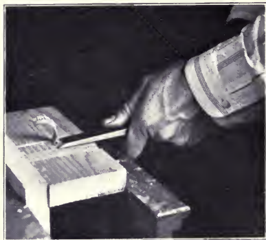
Fig. 70. Chiseling Out a Dado (First Step).
