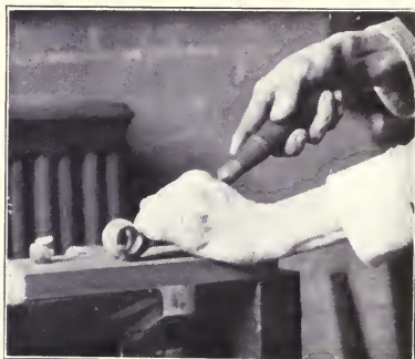
Fig. 82. Gouging.
