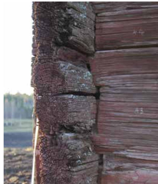
Figur 7.17. Rak halvhaksknut representerar en vanligt förekommande knut i övre Norrland.
