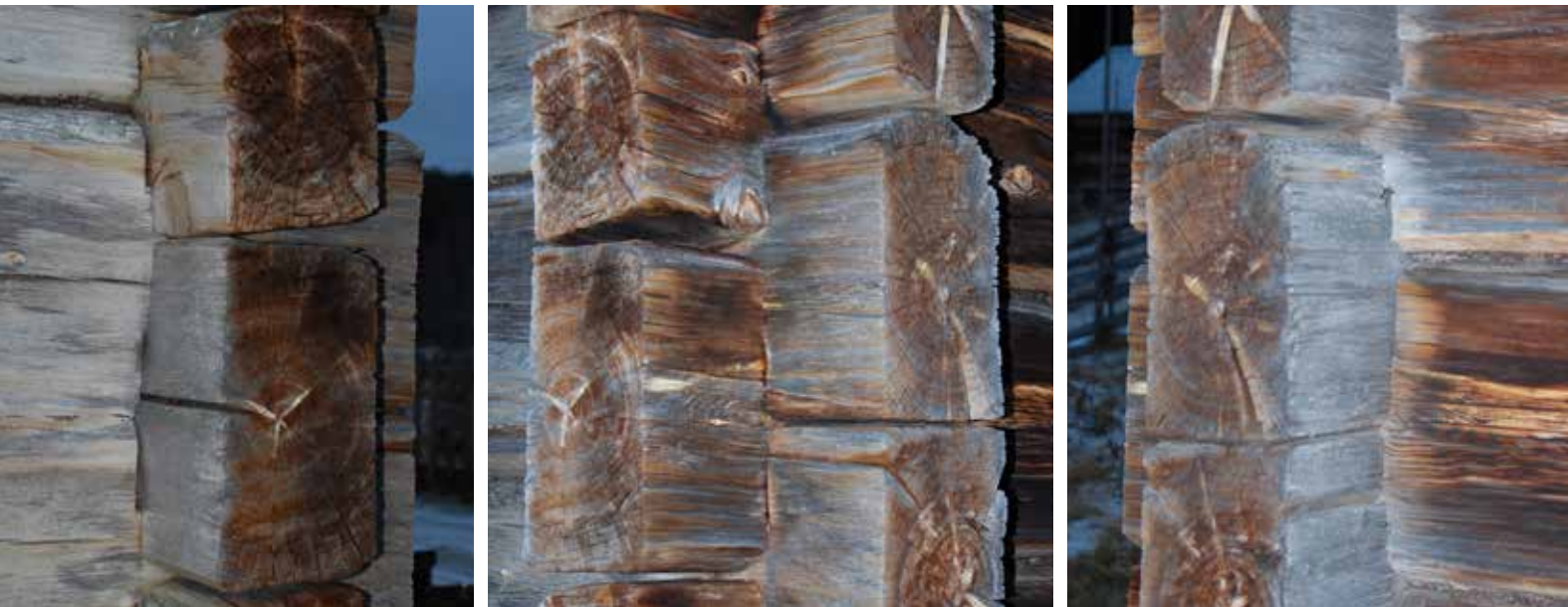
Figur 7.6. Rak halvhaxsknut representerar en vanligt förekommande knut i övre Norrland.
