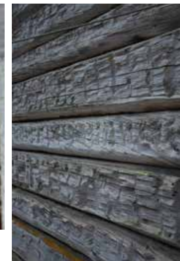
Figur 7.10. En gavelvägg på den äldsta byggnaden i Gallejaur, ett stall från 1830-talet. Väggen är bara förberedd för bilning genom inhugg, grovkläckning, som sitter så tätt att mycket virke avverkats innan själva bilningen skulle påbörjas. Väggen har varit placerad mot en annan byggnad och därför blev det inte nödvändigt att finbila för att förbättra skyddet mot regn och fukt.
