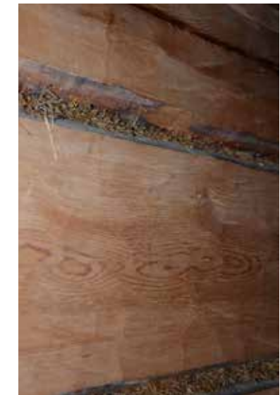
Figur 7.7. De finbilade stockarna på vindens insida, även utsidan var ursprungligen lika fint bilad.
