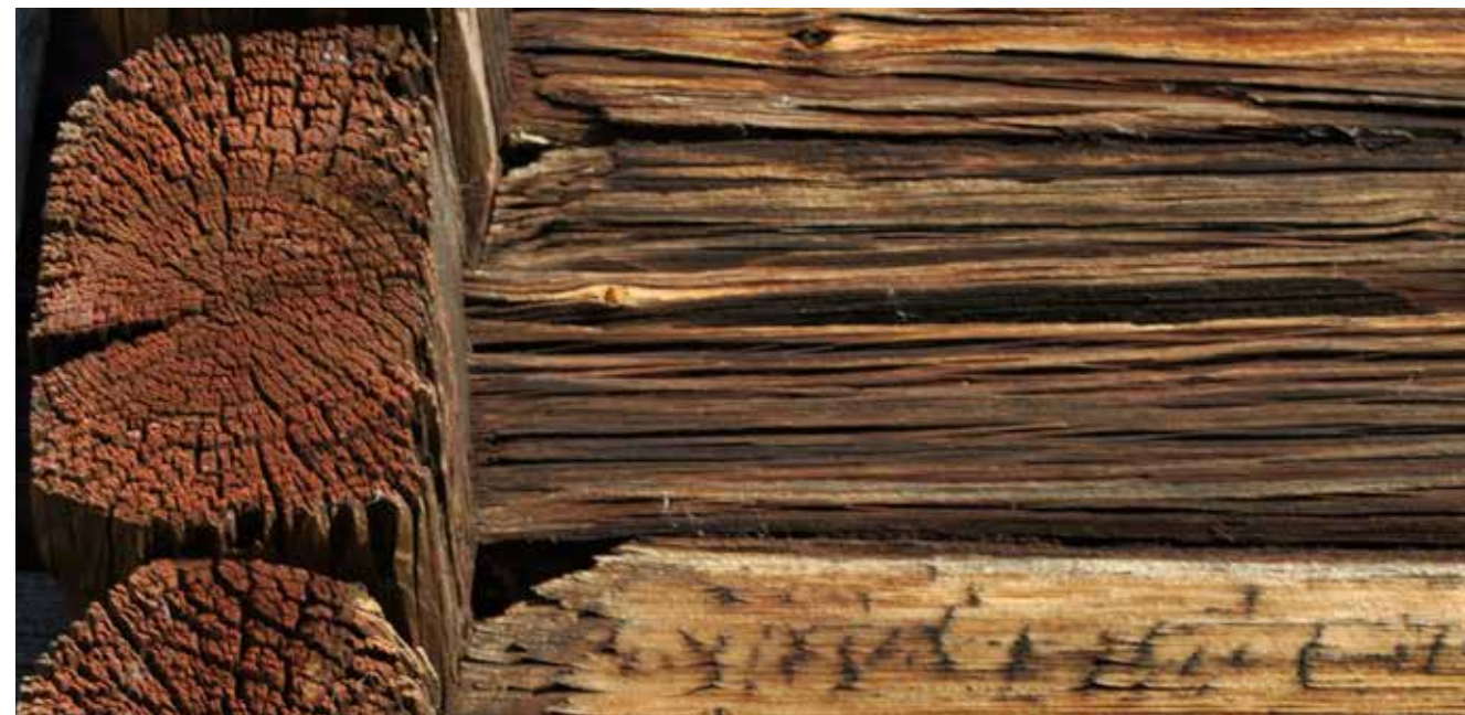
Figur 7.15. Till höger om knutkedjan (BC-knuten i det undersökta huset) ser man små "trianglar" där virket är borthugget. Den här typen av hål, rakt in i rummet innanför, är vanligt i området och kan många gånger vara betydligt större.
