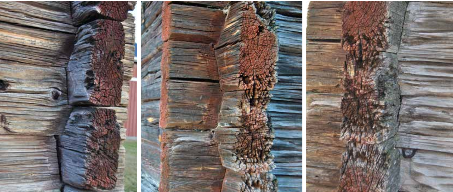
Figur 7.12. Rak halvhaksknut representerar en vanligt förekommande knut i mellersta Norrland och Svealand.
