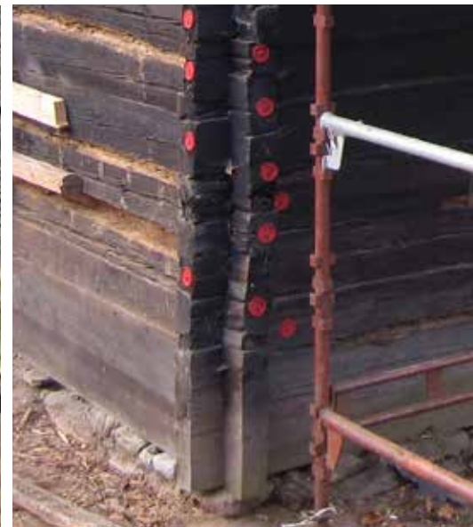
Figur 7.26. Tre foton av Östra härbergets knut. Vid undersökningen var huset nedplockat. Den högra bilden visar dock knutkedjan uppmärkt inför demontering.
