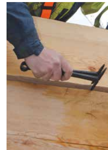
Figur 2.12. Den undre stockens form förs över på den övre stocken. Bilden visar sydsvensk timring som inte har någon såt när stockarna timrats ihop.
