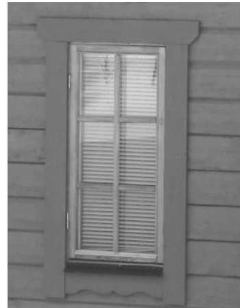
Bild 15. Nytt fönster med passande härjedalsstil (foto Monica Andersson)
