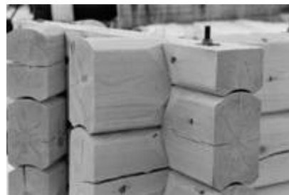
Bild 15. Knut av maskintillverkat timmer med dragstål (foto Monica Andersson)
