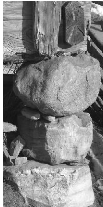
Bild 8. Grundstenar under timmerhus (foto Monica Andersson)
