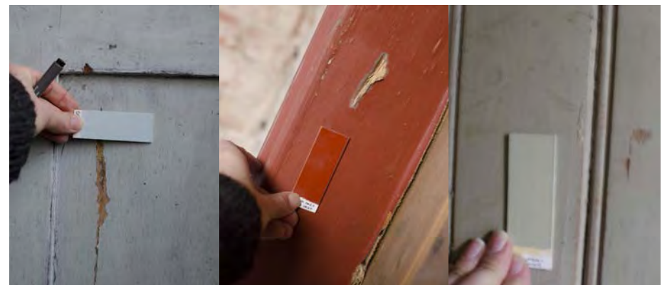
Testing av egne oppstrøk mot eksisterende flater.
