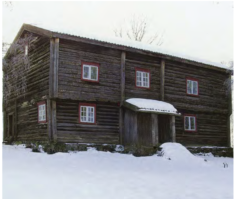
Føderådsbygning fra Skøyen i Løten (1760-80). Foto: Jon Brønne.
