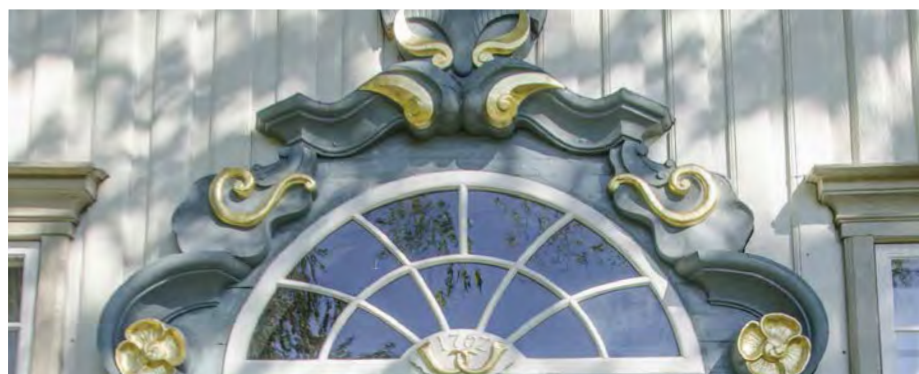
Lerkendal gård, Trondheim (1762). Rokokkodetalj, inngangsparti.v
