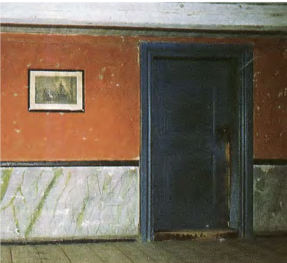
Kvikne; Bjørnstjerne Bjørnsons fødehem. Fargesatt med kraftige empirefarger med limfarge, tidlig 1800-tall. Foto: Jon Brønne.
