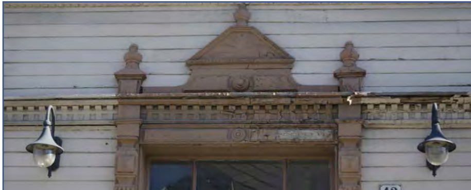
Weidemannsvei 13, Trondheim. Detalj, inngangsparti.
