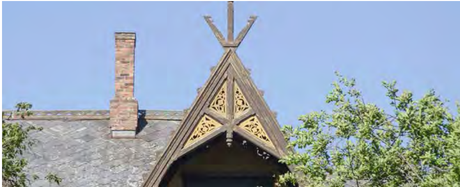
Villa Rognli, Trondheim (1881). Detalj, takutstikk.
