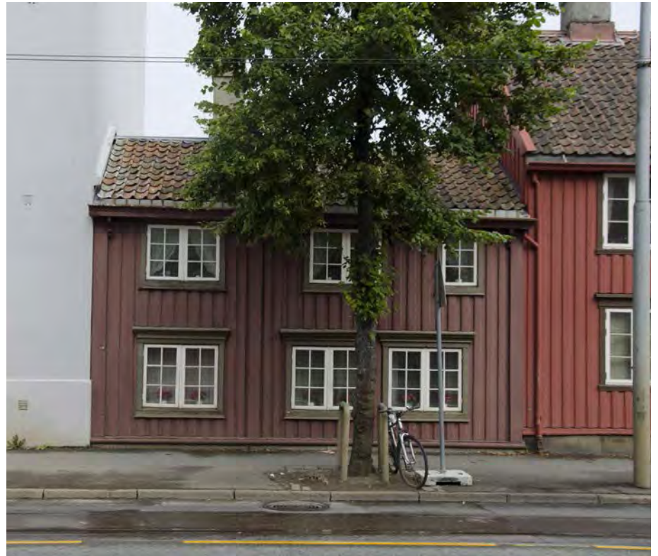
Kongensgate 82, Trondheim (1720-årene). Større vinduer og andre etasje lagt til senere på 1700-tallet.
