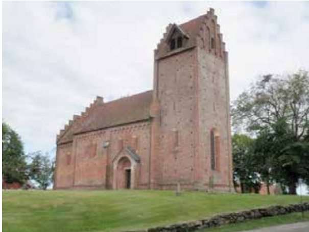
Bild 1. Murverk i tegel uppkommer i Sverige under tidig medeltid. Sveriges äldsta tegelbyggnad är Gumlösa kyrka från 1192. Foto Anders Göransson.
