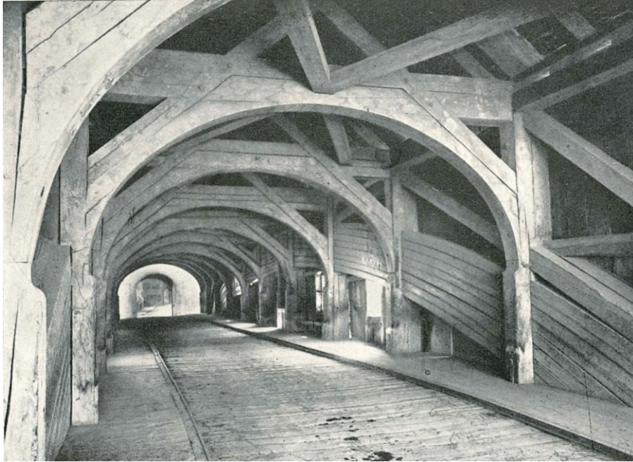
Abb. 42: Die Mellinger Reussbrücke kurz vor dem Abriss 1927 (Brunner 1925)
