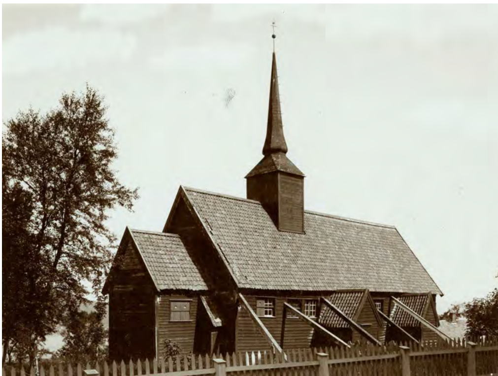
Ill. 5 Kvernes stavkirke, ca. 1900, avstivet med utvendige skorder. I dag er det bare Kvernes og Rødven kirker som har slike støtter. Foto: C. Christensen Thomhav. Riksantikvaren.
