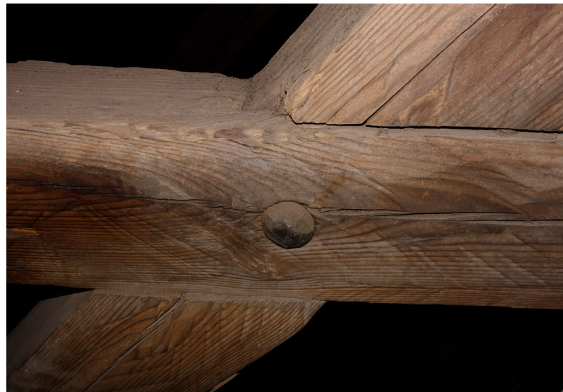
Fig.3. Undersperre med kryssende hanebjelke. Flaten viser upresis spretteljing og skjøten er sikret med en treplugg. Det er ingen bruk av jern i sperretaket. Foto: Morten Stige.
