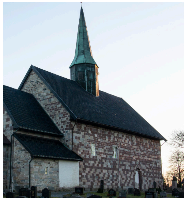
Fig.13. Takrytteren på Rygge kirke, Østfold viser hvordan spiret kan ha vært utformet på Tingelstadkirken. Den åttekantede tårnbasen er ca. 4,5 m. i diameter. Det er helt tilsvarende målene på Tingelstad, men siden Rygge kirke er vesentlig større blir virkningen en helt annen. Foto: Kjartan Hauglid.
