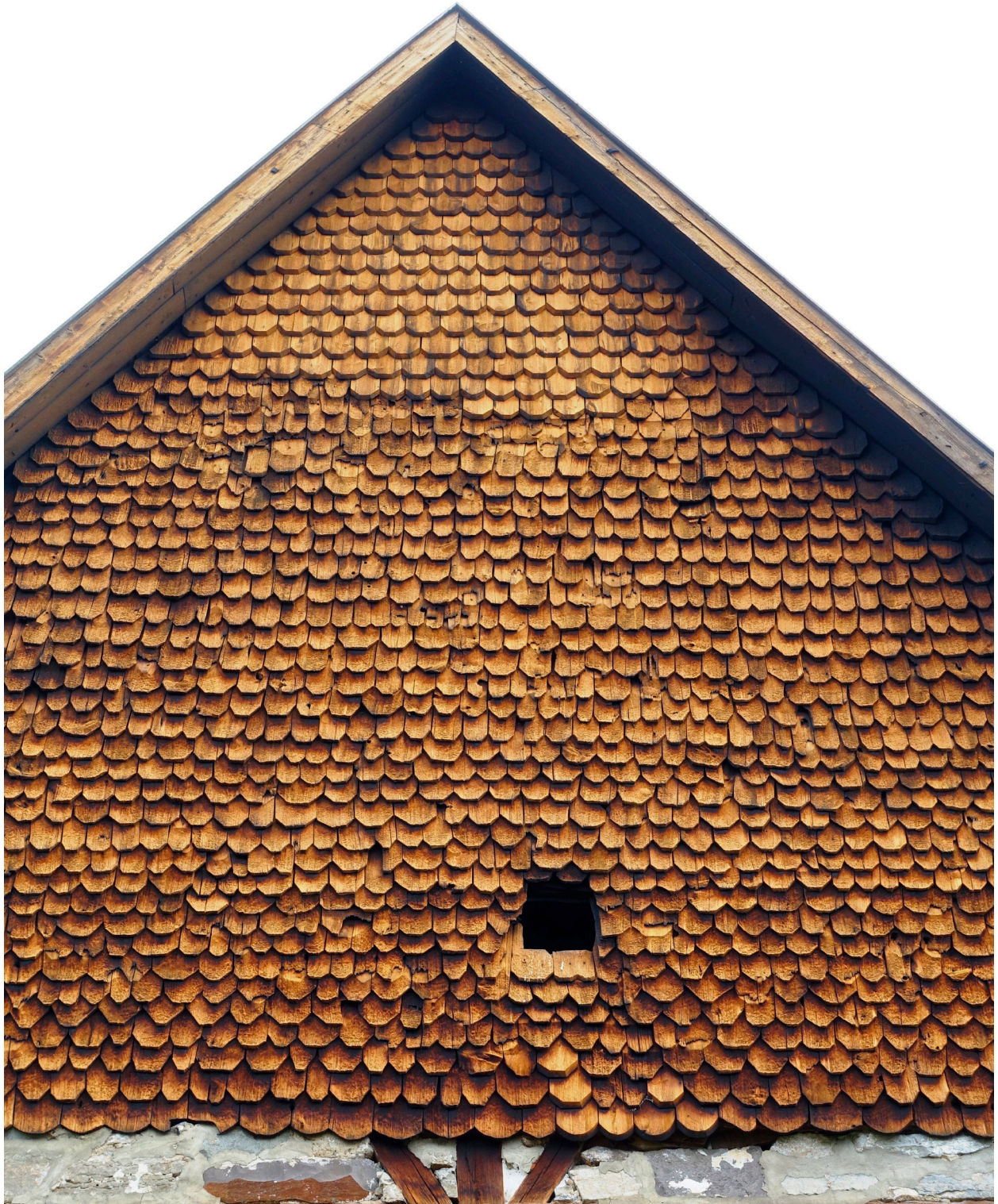
Fig.17. Vestgavlen har en gammel og svært variert spontekking. Der er gammel spon som er innfestet med treplugger bevart. Sperrebindet er fra 1200-tallet og bordveggen har middelalderkarakter. Sammen med slitasjen sannsynliggjør det at denne tekkingen er svært gammel og kan være basert på middelaldertypen. Foto: Morten Stige.
