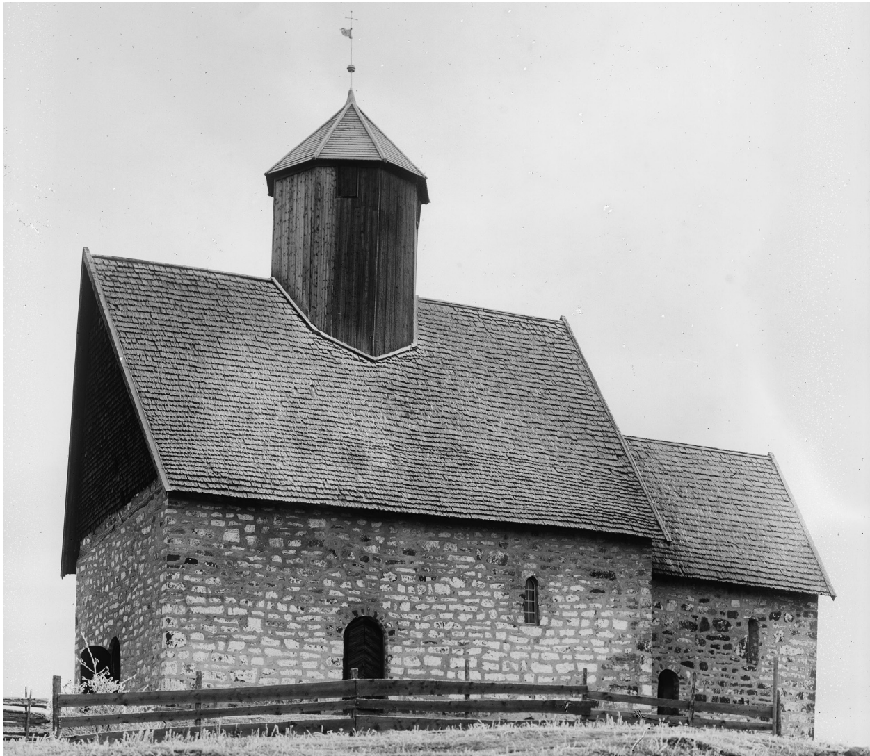
Fig.1. Tingelstad gamle kirke fra sør ca. 1900. Kirken har fortsatt håndkløyvd spon med tilspissing og sterkt varierende størrelse. Foto: Skarpmoen, Nasjonalbiblioteket.
