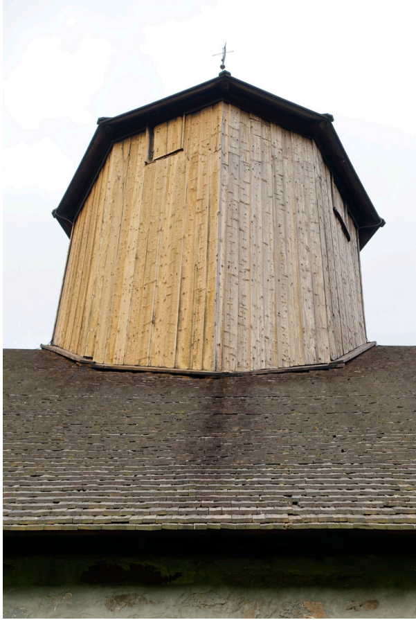
Fig.10. Takrytterens åttekantede base har formen fra sent 1500-tall, men er kledd med nyere panel og har fått en lav kuppel i stedet for et høyt spir. Foto: Morten Stige.
