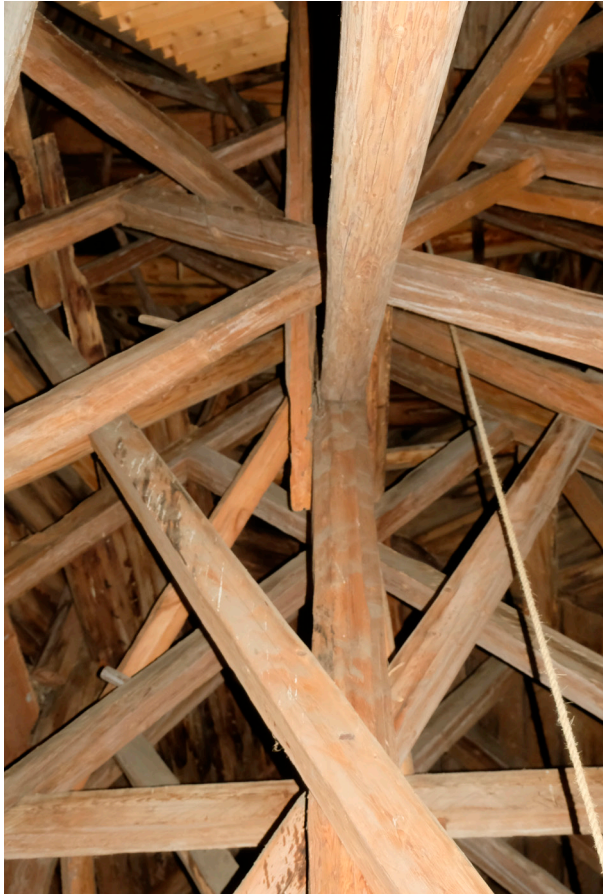
Fig.11. Sett fra loftsgulvet er tårnkonstruksjonen mer krevende å forstå. Ved første blick ser det ut som et kinesisk pinnespill, men ved nærmere ettersyn kan en skjelne den åttekantede hovedkonstruksjonen rundt den stående midtpilaren; «kongen». Foto: Morten Stige.
