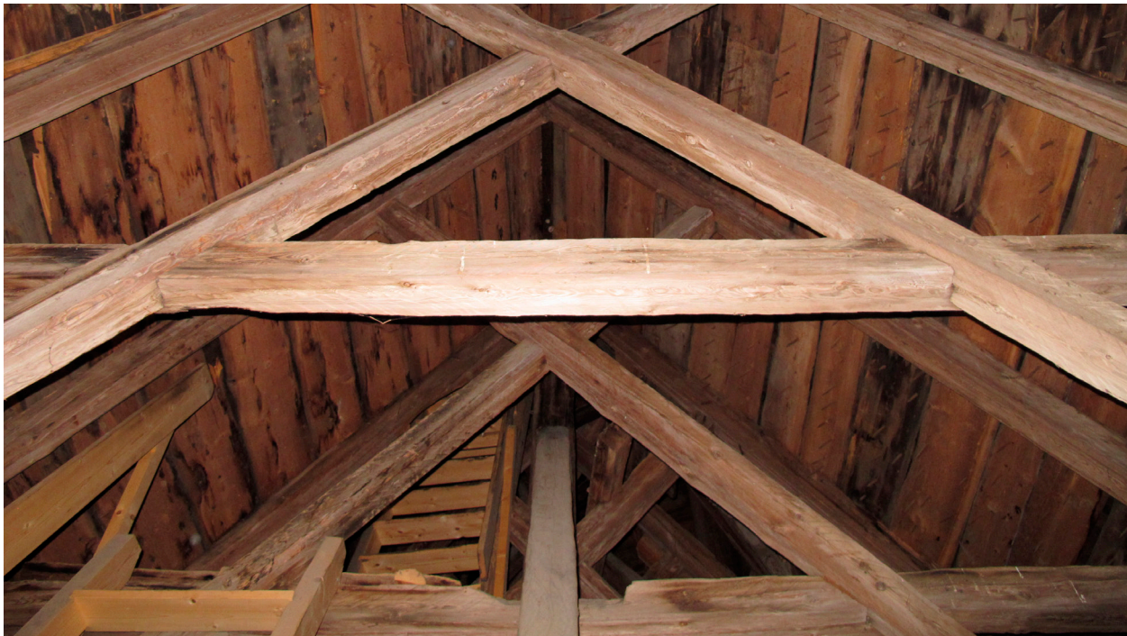
Fig. 5. To av skipets sperrebind sett fra vest. Stigene opp i takrytteren både foran og bak i bildet. Foto: Morten Stige.
