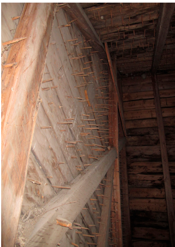
Fig.7. Innsiden av vestgavlen. De liggende bordene med de karakteristiske trenaglene som fester spontekkingen. Foto: Morten Stige.
