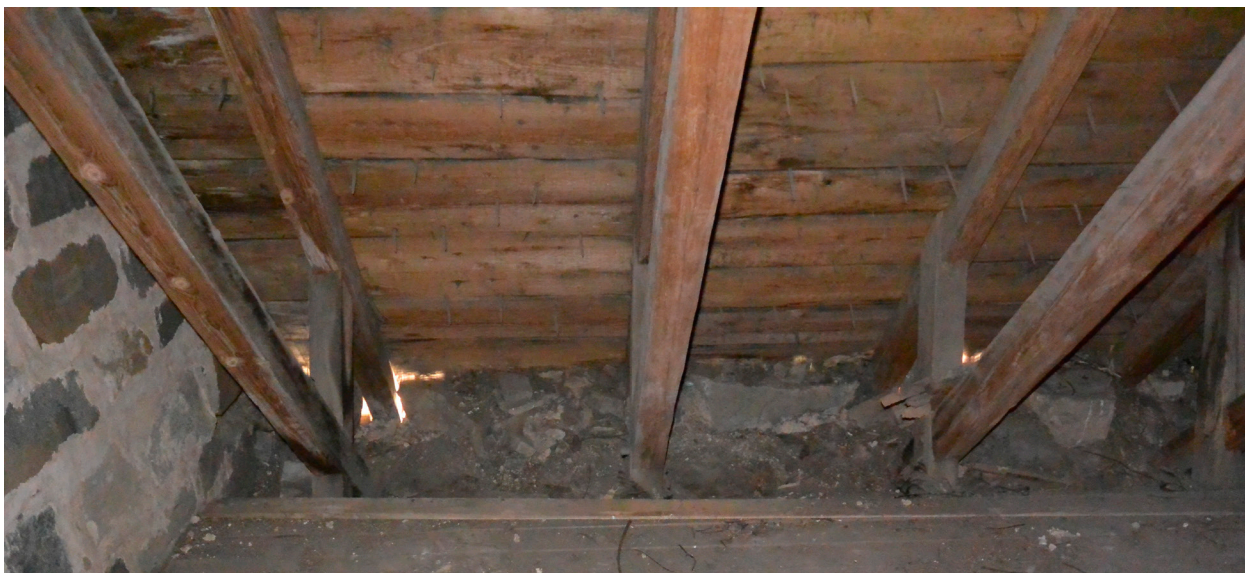
Fig.16. Korets tak. Takbordene er stort sett skiftet ut med sagde bord som ligger kant i kant og ikke med overlapp som et sutak. Det er ingen spor i sperrene etter tidligere sutakslegging. Vestgavlen, som har undertak av middelaldertype, er også lagt kant i kant. Det gir et luftig og utett undertak som er helt avhengig av spontekkingen for å holdes tørt. Trenagler fra eldre spontekking er synlig på bildet. Foto: Morten Stige.
