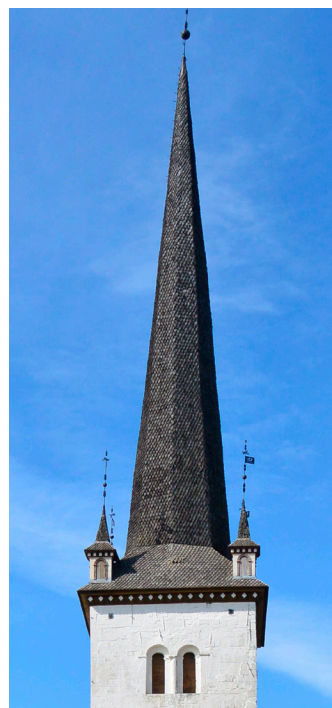
Fig.13. Takrytteren på Rygge kirke, Østfold viser hvordan spiret kan ha vært utformet på Tingelstadkirken. Den åttekantede tårnbasen er ca. 4,5 m. i diameter. Det er helt tilsvarende målene på Tingelstad, men siden Rygge kirke er vesentlig større blir virkningen en helt annen. Foto: Kjartan Hauglid.
