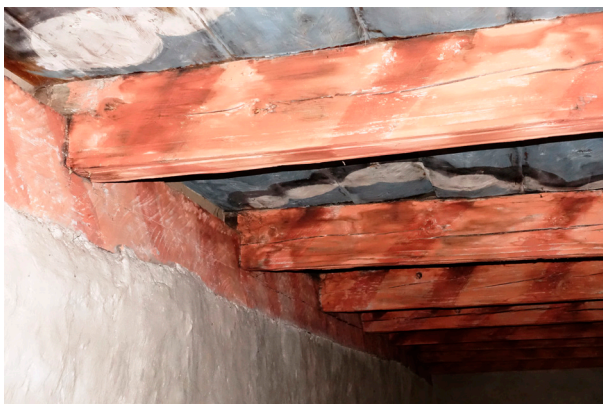
Fig.6. Himling i skipet. Bemalingen er datert anno 1701, men himlingsbordene kan være eldre. Legg merke til profilene langs kantene på bindbjelkene. De er nedfelte i murremnen og hører til sperrebindet, profilen viser at de er av middelaldertype og ganske sikkert opprinnelige. Foto: Morten Stige
