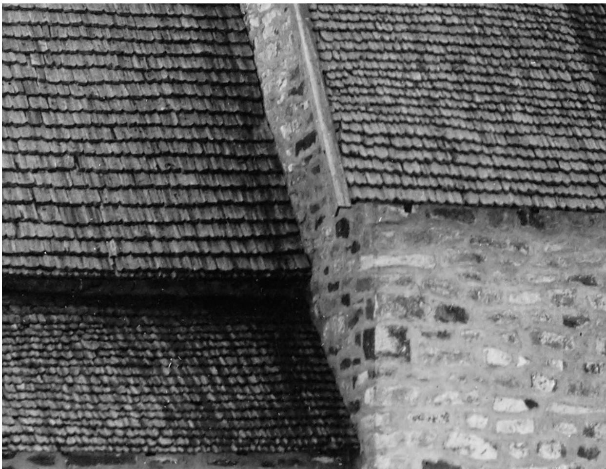
Fig.19. Detalj av foto fra ca. 1900. Det ser ut som om mange av sponene er utformet med to spisser. Det er stor variasjon i størrelsen på sponene. Ut fra opptelling av spon på bildet får vi et gjennomsnitt på ca. 44 spon/m 2 . Foto: Riksantikvaren.
