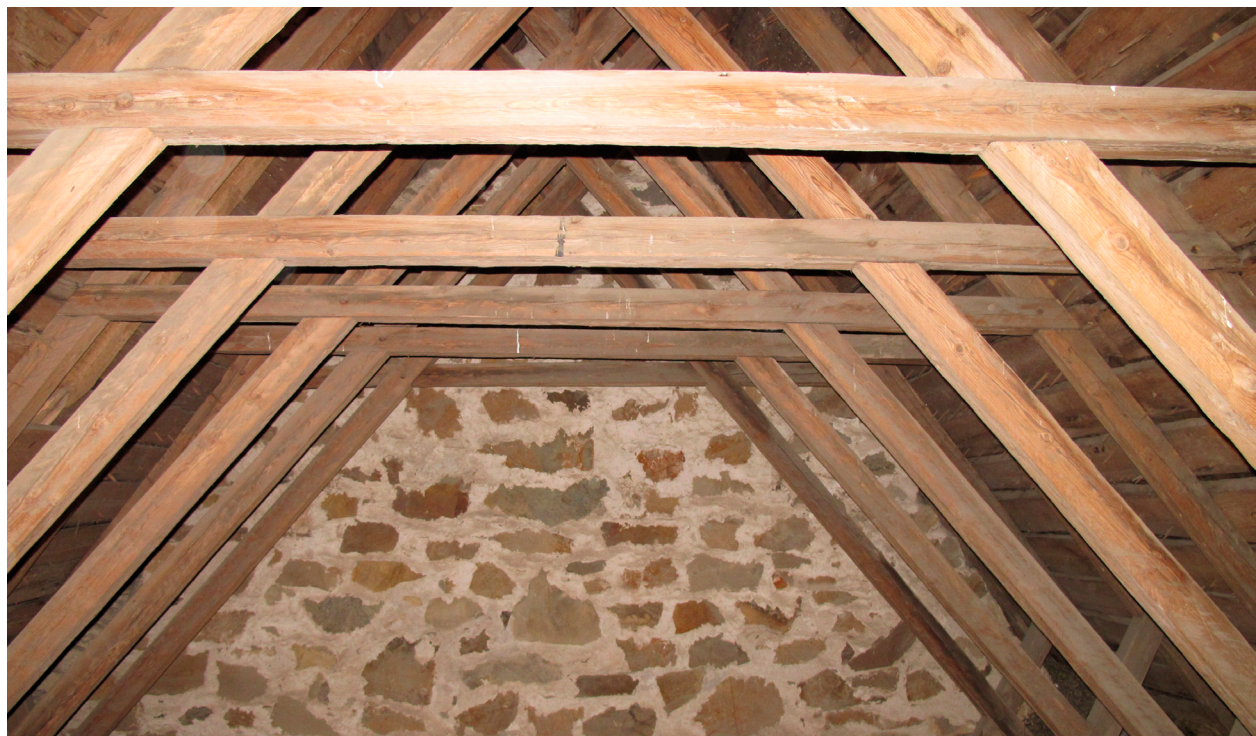
Fig. 9. Takverket i koret sett mot den murte østgavlen. Foto: Morten Stige.
