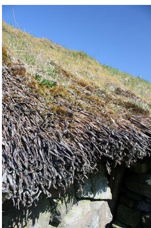
Figur 4: Hus G i Auchindrain Township, Skottland. Øverste bilde viser mønetorv og en reparasjon. Detaljbildet viser det svarte rotfeste til bregnen Einstape. Nederst til høyre bygningen slik den står i dag
