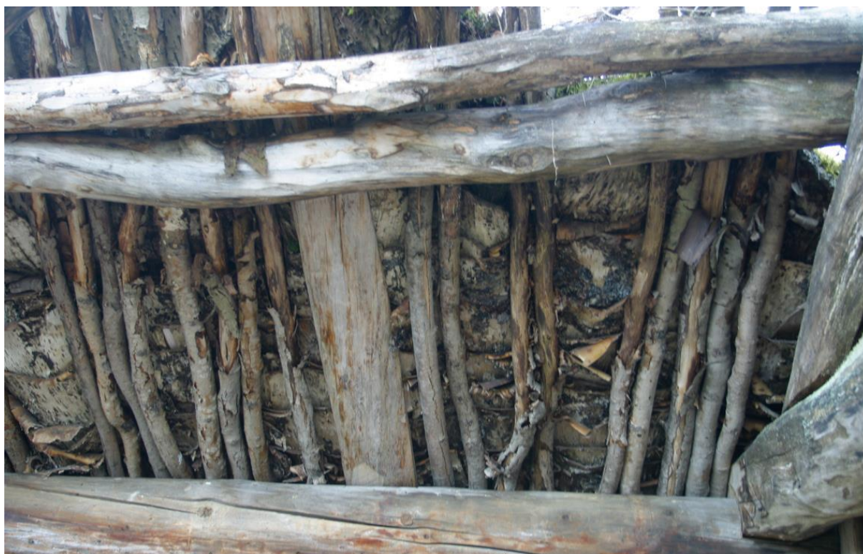
Tro av staur eller tynne rajer. Her ser ein tydeleg nevra som er omhyggeleg lagt i raster, med kvitsida ned. Høysjø i Salangen, Troms. (foto: Roald Renmælmo)
