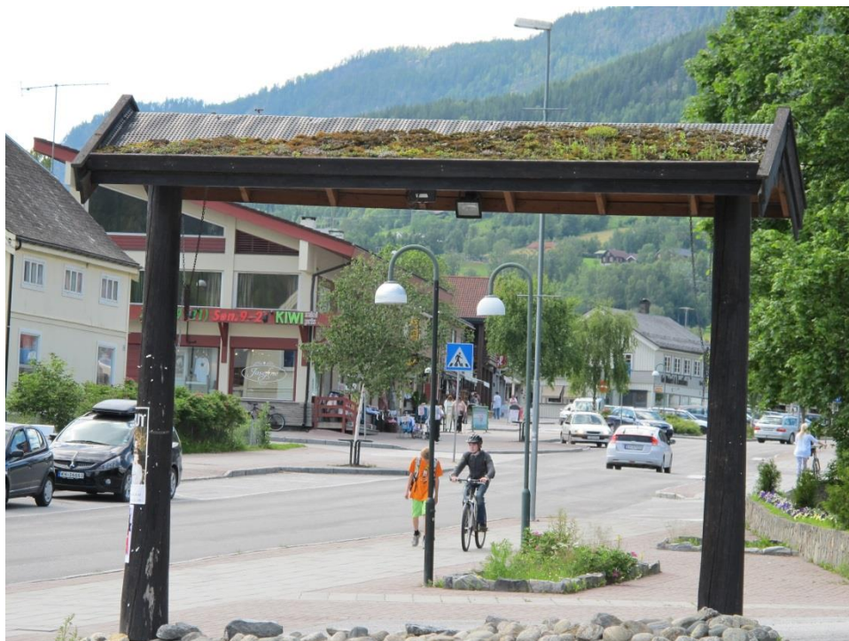
Portal med moderne torvunderlag i Gol sentrum. Moderne "tactorv" med høgt innhald av Sphagnum-moser vil raskt forvitne og forsvinne.
