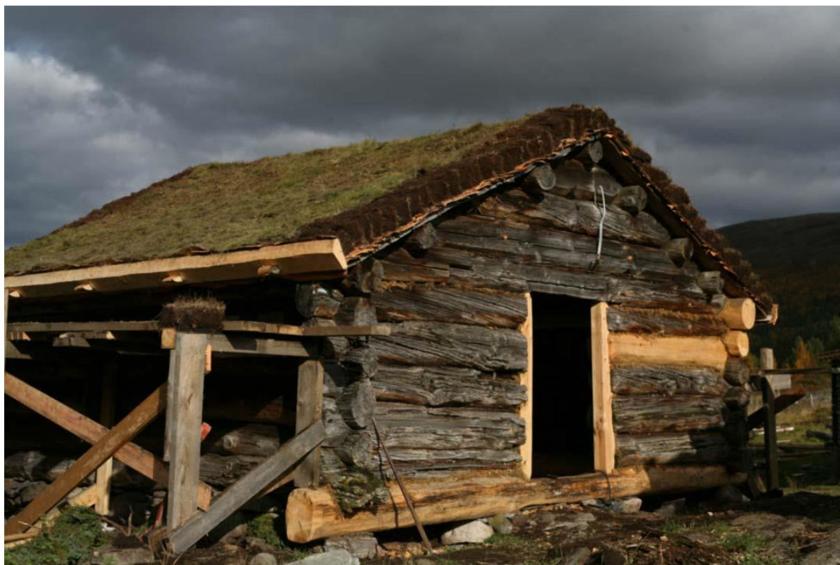
Nylagt tak med torv og never på Kalven seter, Lemonsjøen. I Gudbrandsdalen er tradisjonen å bruke "kanttorv" for å gjere enden av torvsjiktet meir robust mot slitasje.
