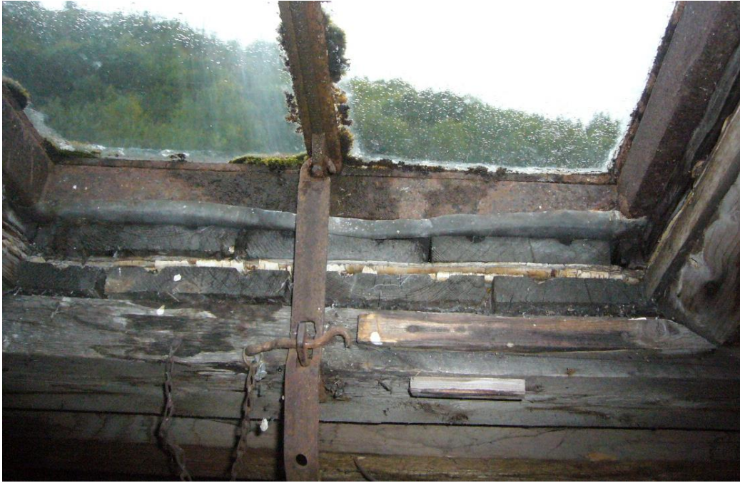
Dobbelt bordtak med never er brukt som undertak for skifertekking på Rønvik sjukehus, Bodø.
