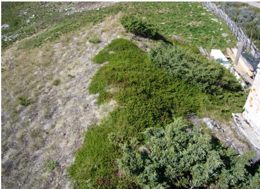
Taket på Flaksjølien Jakthytte, sett vestover langs mønet. På sørsida (til venstre) er det svært tørt, og der finn vi berre eit tynt dekke av få, små og tørkesterke grasartar. På nordsida av mønet er det derimot tjukk vegetasjon med fleire artar, der røsslyng og einer er dominerande.
