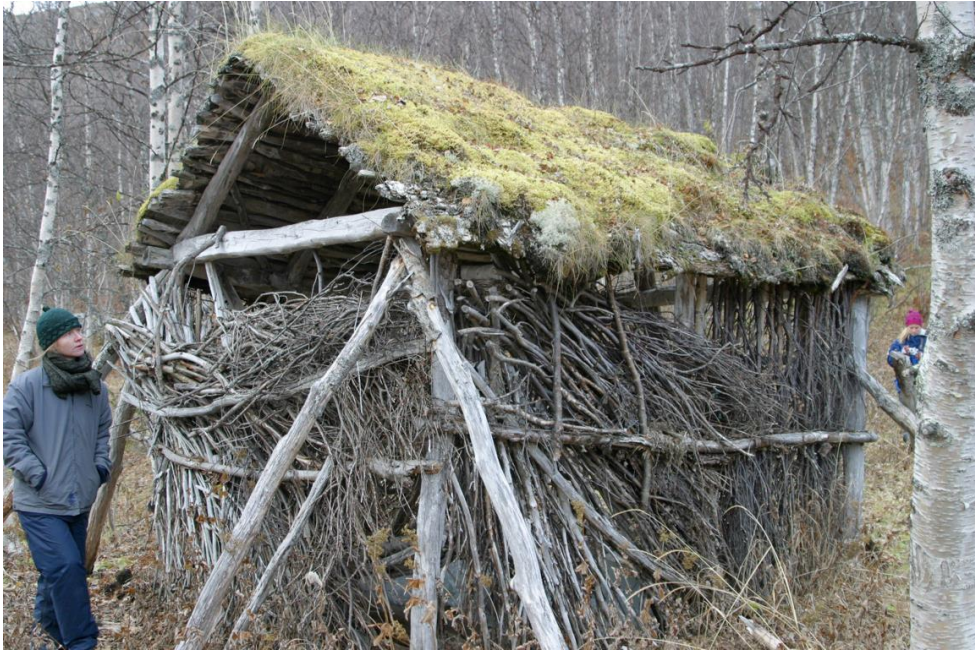
Høysjå med risveggjar i Skjerstad. Her er takvinkelen truleg kring 40 grader.(foto: Roald Renmælmo)
