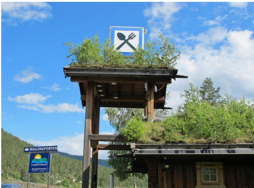
Døme på moderne tak med Sphagnum-torv, slik det kan utvikle seg. Torvmyr-torv med lite vegetasjon og høgt gjødselinnhald gjer at tresortar og andre uønskte planter etablerer seg lett. Legg også merke til området under "tårnet" der torva har tørka og blåse bort.
