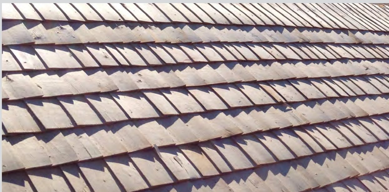
Figur 3.27. Det växelvis lagda taket av granspån.
