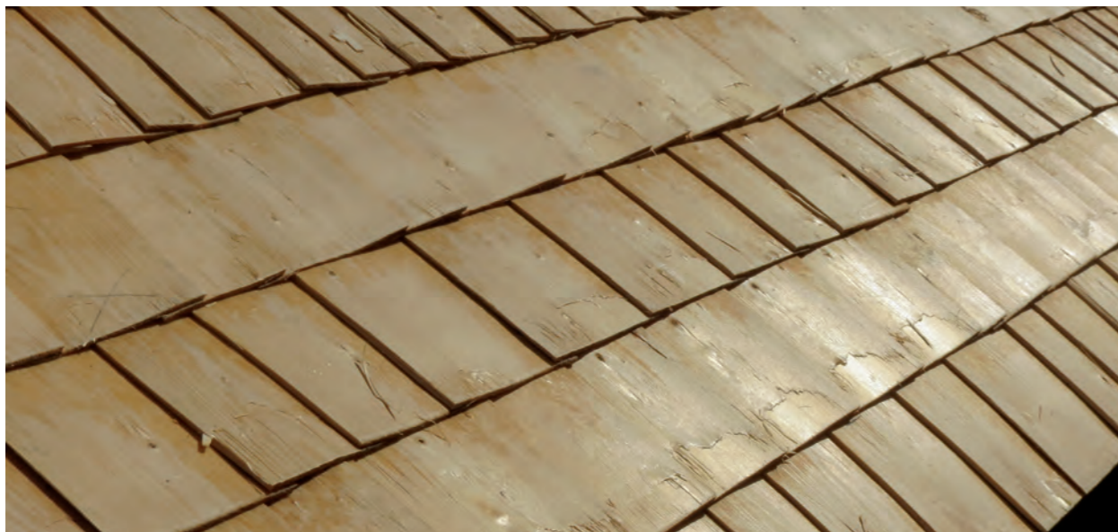
Figur 3.4. Hyvlade granspån växelvis lagda från vänster respektive höger.
