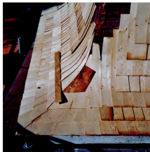
Figur 3.16. Alla skift över hörnet kompletterades med inskott.
