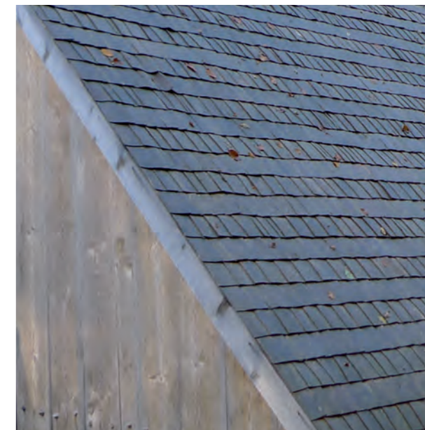
Figur 3.9. Tak med vindskiva där spånen täcker skarven mellan tak och vindskiva.
