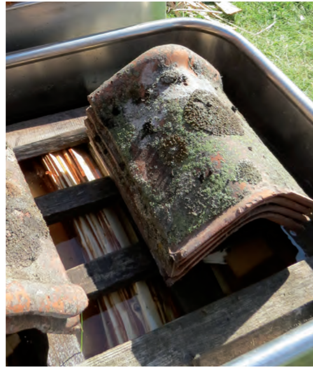
Figur 3.1. Blötläggning av spån i rostfria kar med nockpannor som tyngd.
