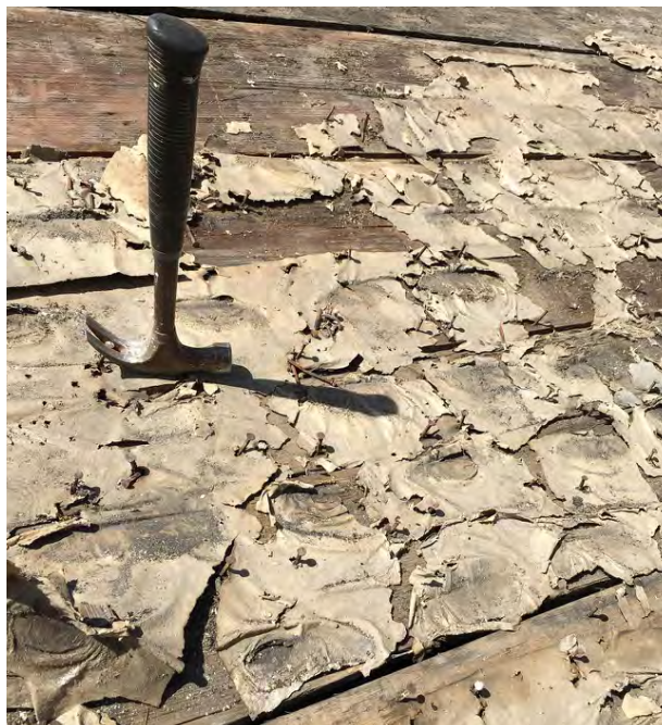
Figur 26. Oändligt många spikar att dra ut. Under det borttagna skiffret låg papp. Foto: Emil Engqvist.
