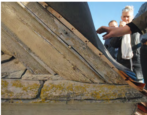
Figur 31. Detaljbild av en inpassad vindskiva på Bro kyrka, Värmland. Det nya underlagstaket av råspont har lagts ovanpå underbrädorna. Den gamla vindskivan måste kompletteras för att dölja råspontens ändträ, vilket bör göras så diskret som möjligt. Foto: Emlan Wolke.
