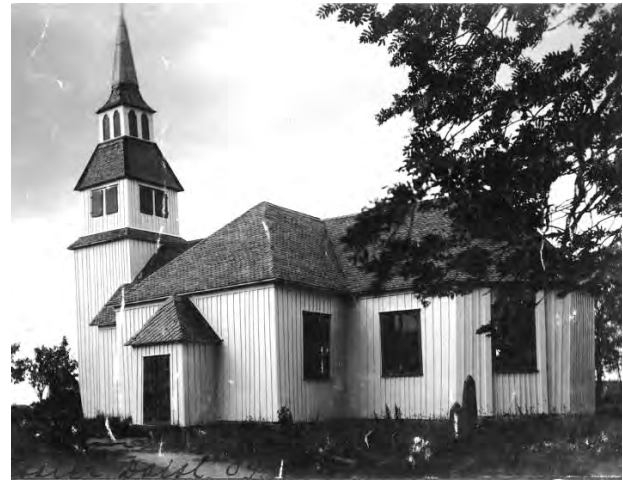
Figur 40. Äldre odaterat fotografi av Gesäter kyrka som skiffertaket en gång såg ut utan nockplåtar. Foto: Sigfrid Gunnäs, Kulturmiljöbild, Riksantikvarieämbetet, Public Domain.
