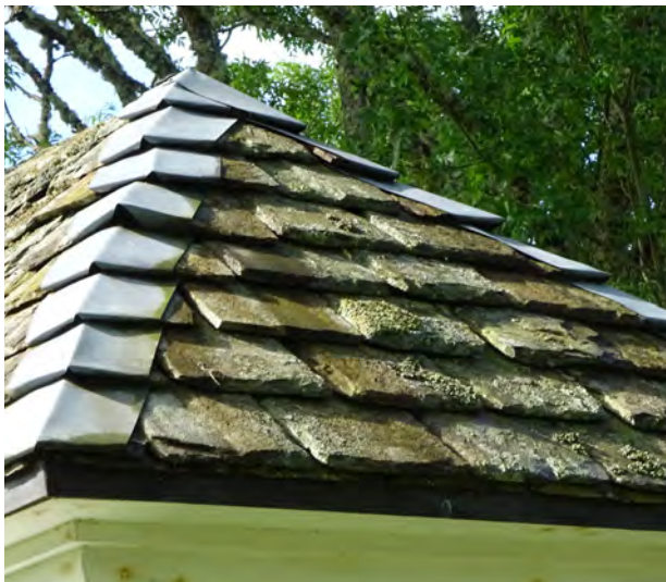
Figur 37. Här har plåt använts för att få en tät snednock. Det är oklart hur det såg ut tidigare men en traditionell lösning utan plåt hade varit att hugga ihop skifferplattorna. Foto: Takskifferprojektet i Karlstads stift.
