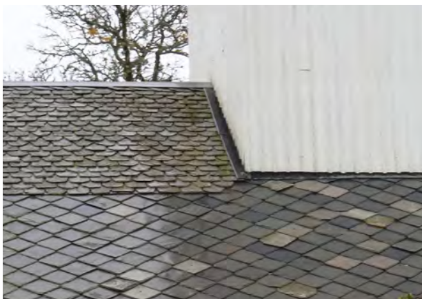
Figur 11. Vid en komplettering av skiffret har ett mindre format lagts på taket. Foto: Takskifferprojektet i Karlstads stift.
