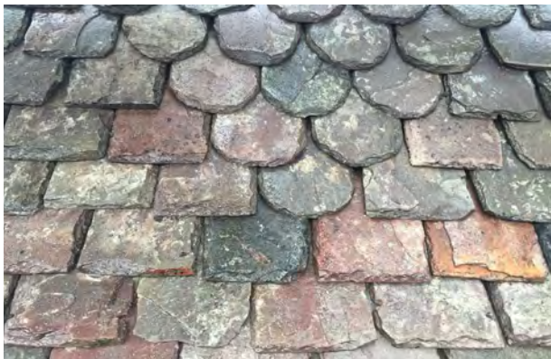
Figur 22. Utifrån glavaskiffer med både rektangulär och rund kant har takfallet smyckats med ett dekorativt mönster. Köla kyrka. Foto: Maria Eld.
