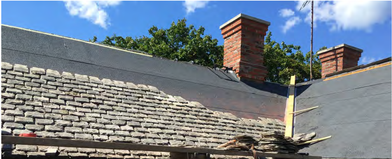
Figur 21. Pågående omläggning med nytt underlagstak och takpapp. Foto: Emil Engqvist.
