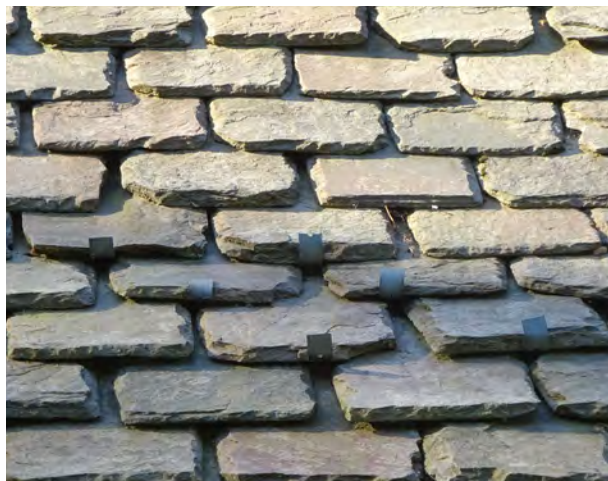
Figur 17. Krokar av bandplåt har använts för att hålla skifferlagningarna på plats. By begravningskapell. Foto: Takskifferprojektet i Karlstads stift.
