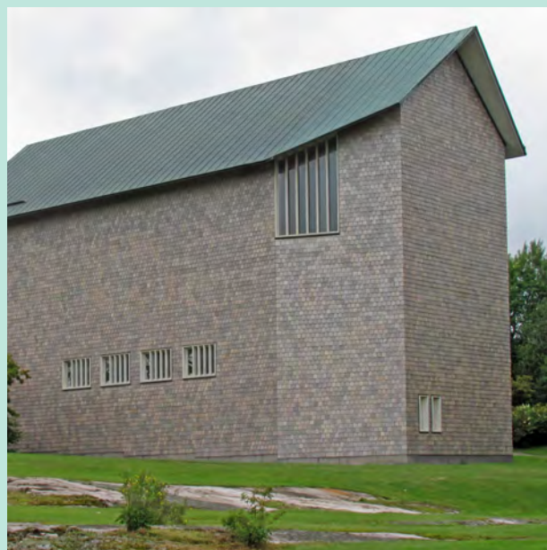
Figur 44: Storfors kyrka med skifferklädd fasad av glavaskiffer. Kyrkan uppfördes efter ritningar av arkitekt Tor Engloo och invigdes 1959. Foto: Larske, Wikimedia commons.
