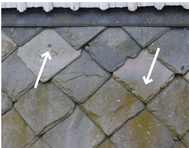
Figur 25. I detta spetshängda skiffer finns lagningar med både krok och spik. Foto: Takskifferprojektet i Karlstads stift.
