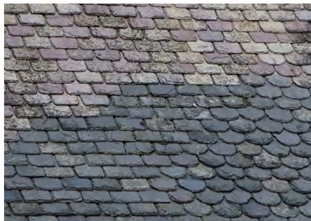
Figur 12. Ett avskräckande exempel på ett illa lagt tak där skiffer av olika typer och storlekar blandats utan ordning. Foto: Takskifferprojektet i Karlstads stift.
