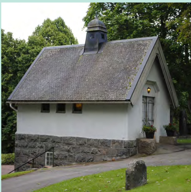
Figur 43: Bårhus vid Kroppa kyrka, Nykroppa, före den omläggning av skiffertaket som gjordes 2019. Då gjordes plåtnock och vindskiveplåt smäckrare (mer lika originalet). Foto: Värmlands Museum.
