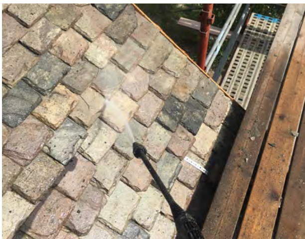
Figur 18. Tvättning av ett nyomlagt skiffertak med högtryckstvätt. Foto: Emil Engqvist.
