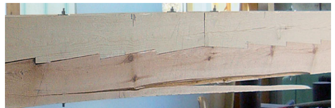
Bild 16 Zahnbalken Nr. 1 – Bruch durch Riss an der Zugseite Composite beam No. 1 – break on zone subject to tension
