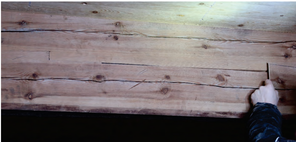
Figur 35 Midten av drageren har ikke møne. Foto PSP
