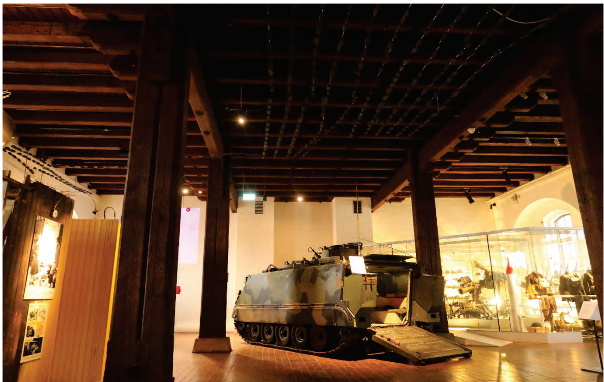
Figur 66 Langsgående kammadragerer og et bjelkelag av kamma bjelker på tvers av bygningen. foto PSP
