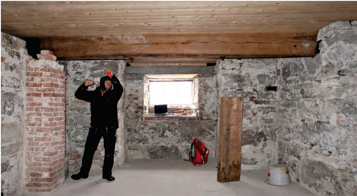
Figur 33 Magne Kleiveland snorer underkant bjelke for å sjekke pilhøyde. Foto PSP
