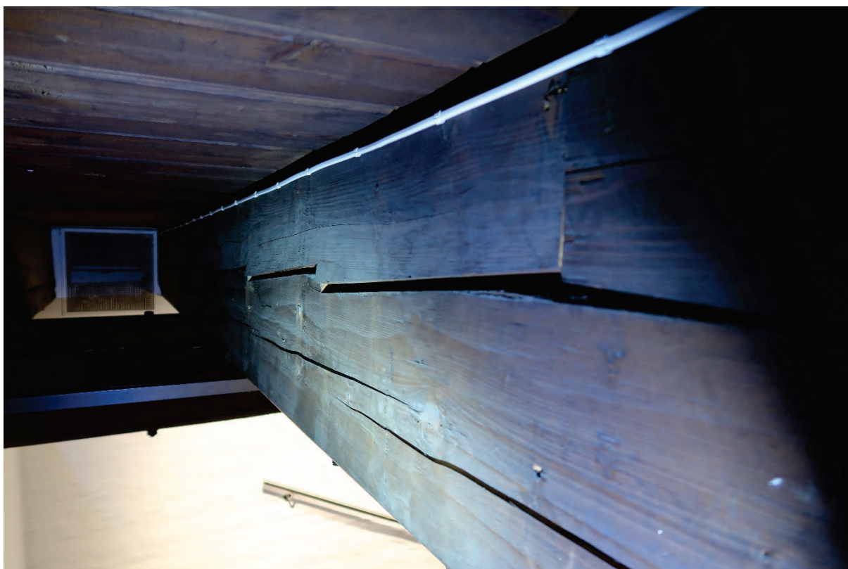
Figur 71 Overstykket har vridd seg en centimeter, så vi kan se inn i kamflata. Foto PSP
