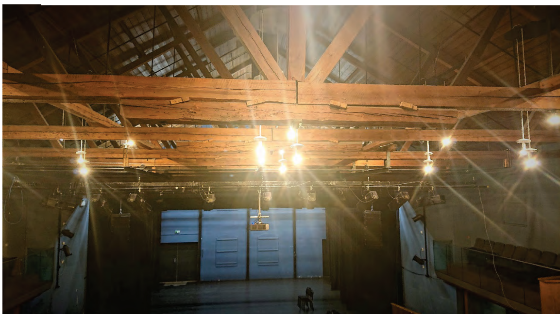
Figur 11 Fordyblet samhald i taket på Dampsaga, Steinkjær. Det er brukt skrå bjørkekiler. foto PSP
