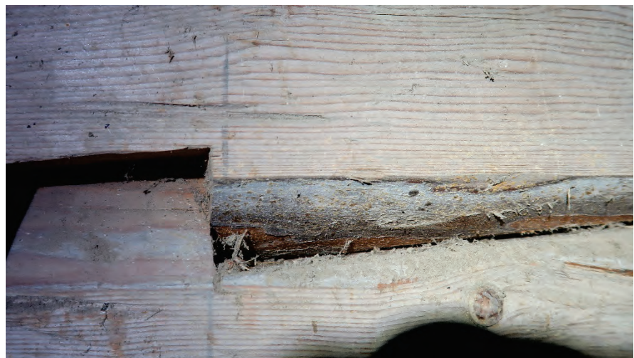
Figur 49 Merking og uttak av kam, foto PSP
