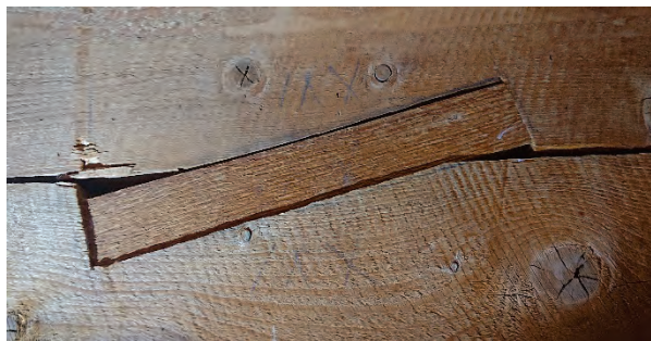
Figur 9 Detalj av skråstilt dybel, Ørens bakeri, foto PSP
