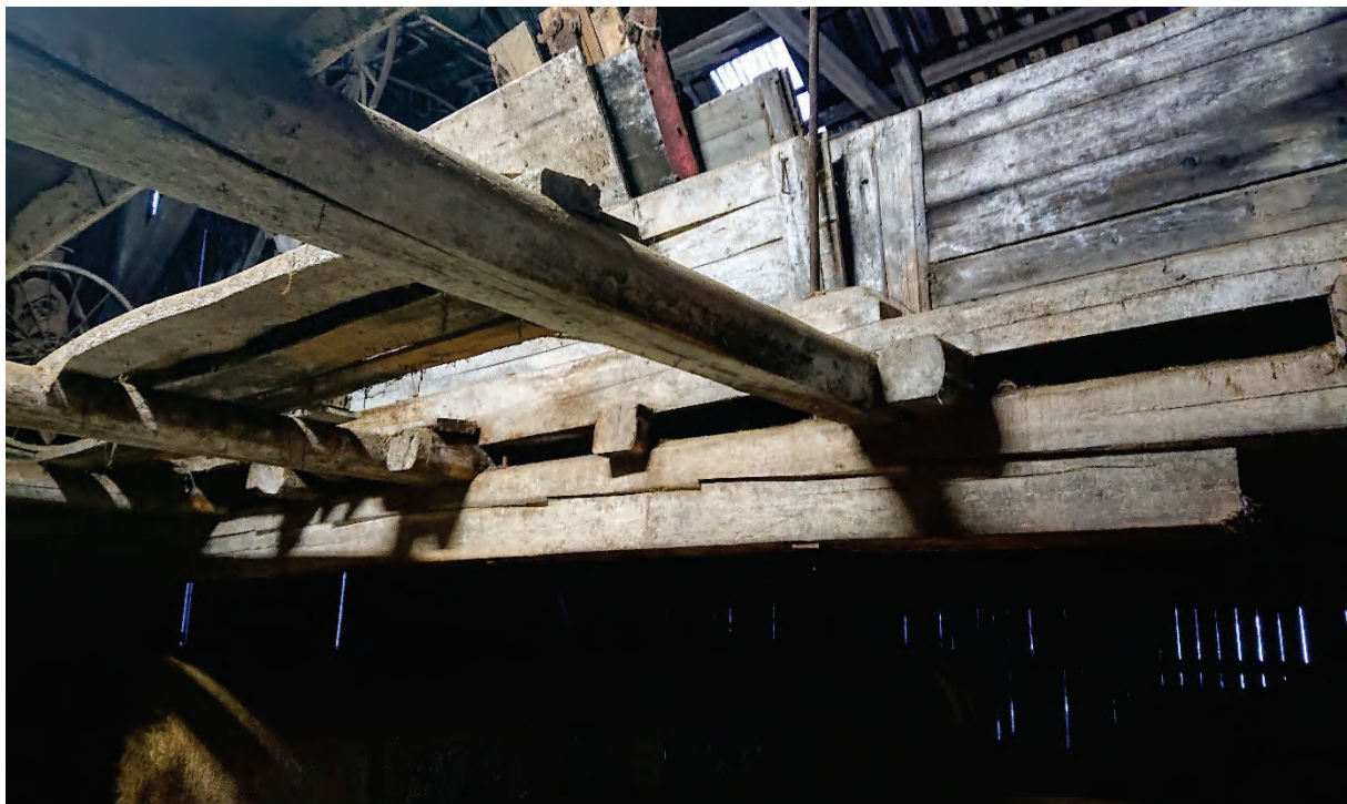
Figur 57 Konstruksjonen sett fra høylaet, foto PSP
