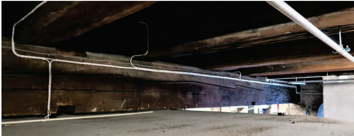
Figur 26 Ca 7 av 9 meters drager, Foto PSP
