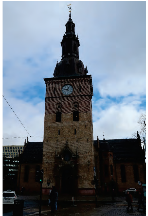
Figur 25 Oslo Domkirke, foto Pål Sneve Prestbakk
