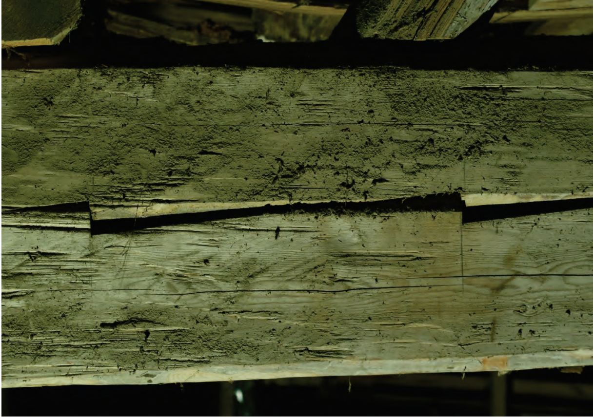
Figur 51 Loddsnitt til siden for merking. Vankant i hele kamhøyden. Foto PSP
