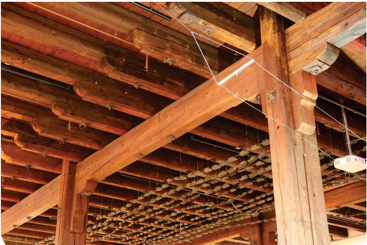
Figur 69 Langsgående drager over to søyler og vi ser utkragningen av bjelkelaget. Foto PSP
