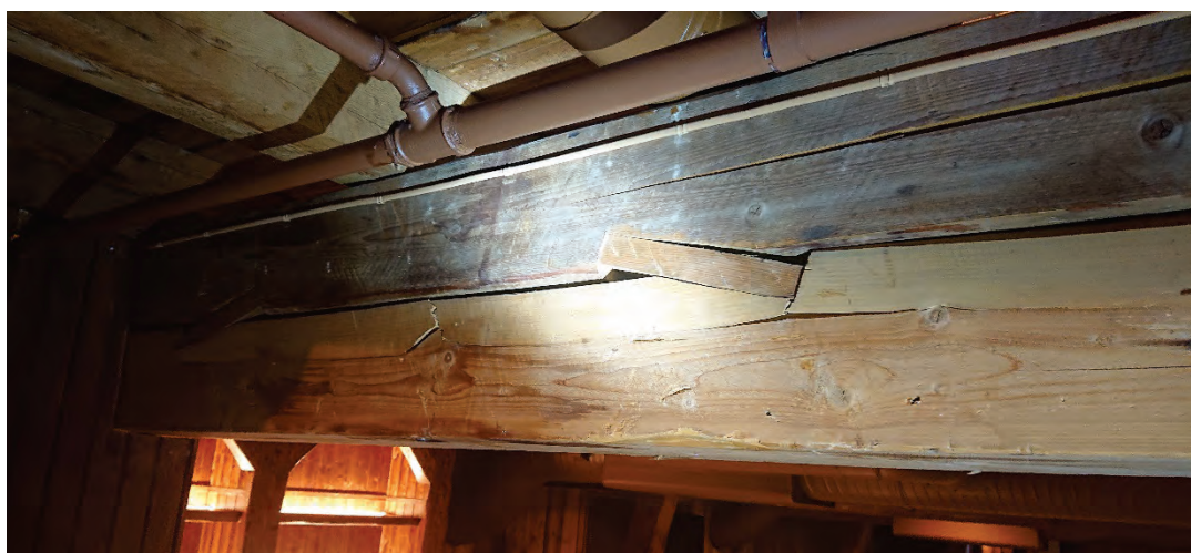
Figur 10 Knusning av ved, fordybling, Ørens bakeri. Foto PSP
