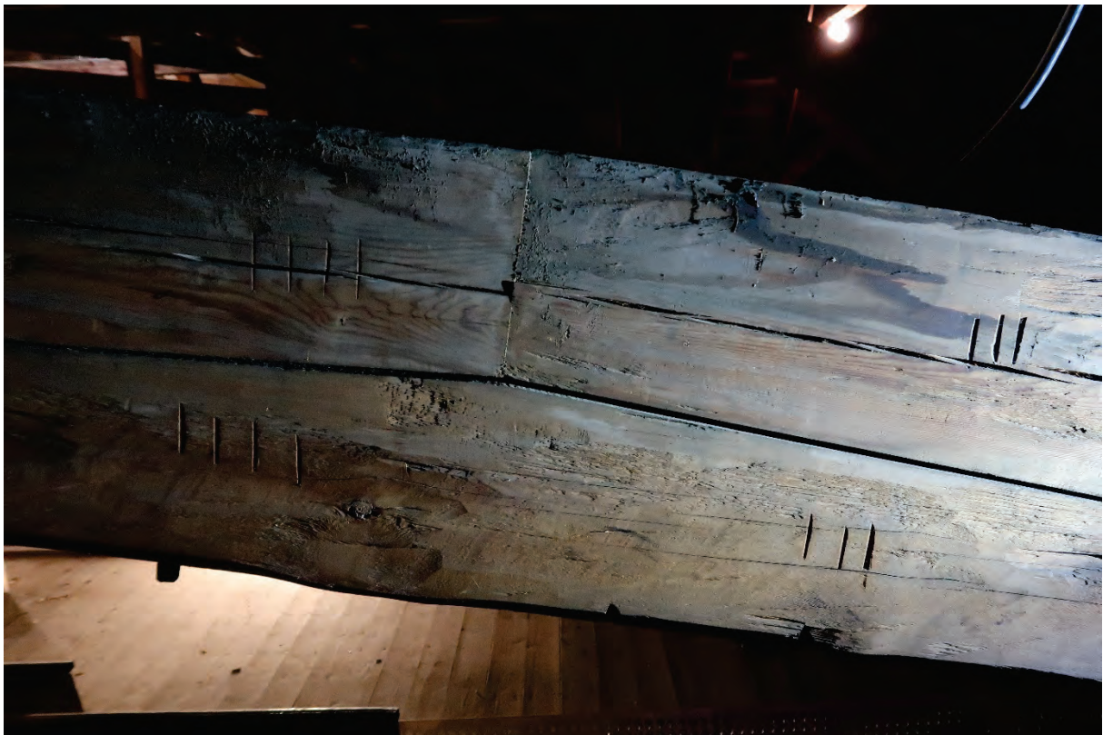
Figur 63 Baksiden av drageren har tydelig merking for plassering av overstykkene. Foto PSP
