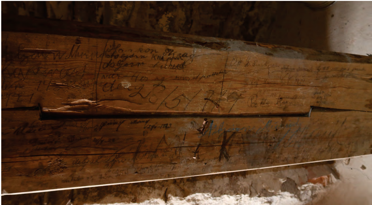
Figur 38 Seksjon fra demontert kammadrager, her ser vi også midtseksjonen uten «møne» også, foto PSP
