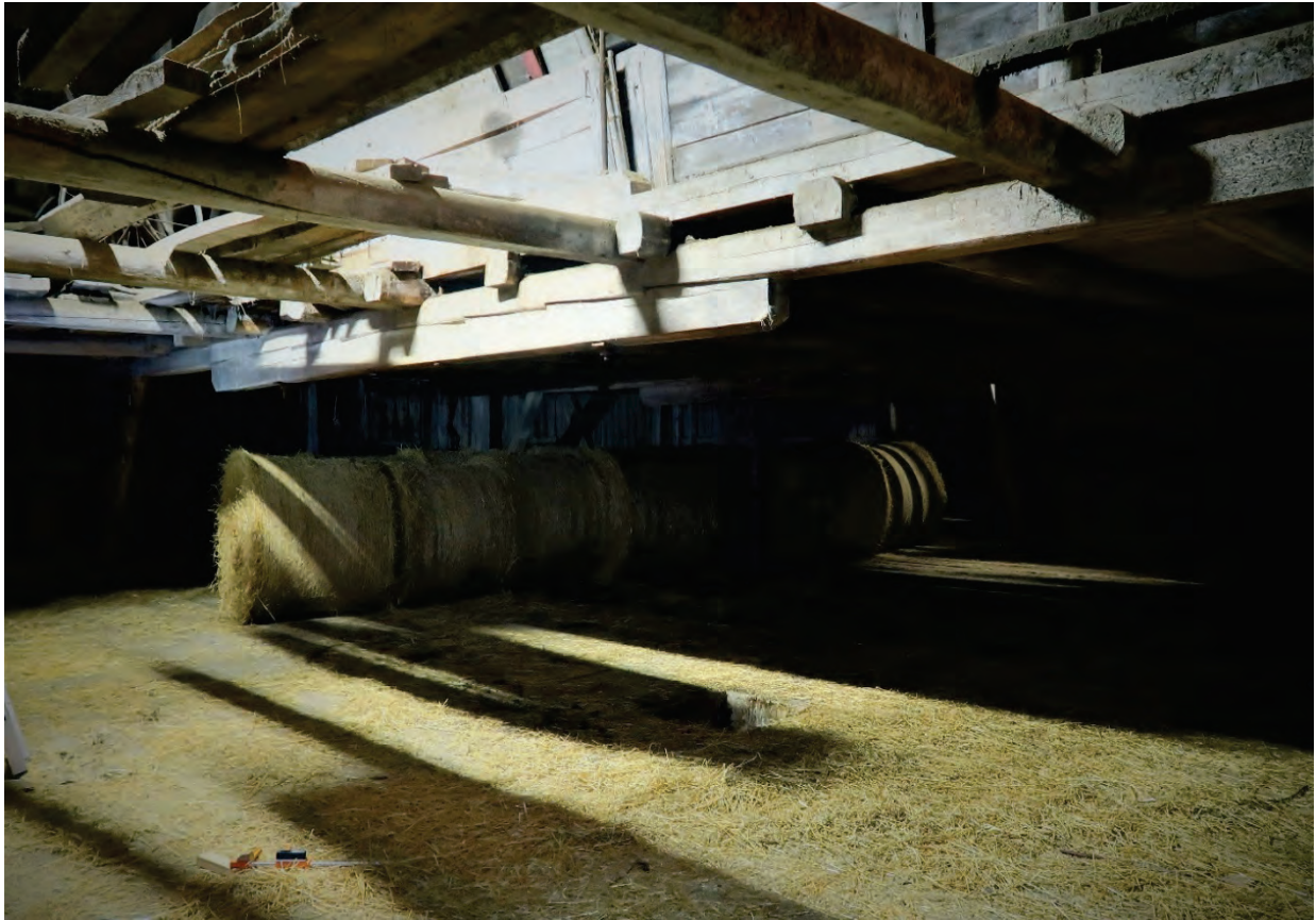
Figur 56 Det søylefrie rommet under bro-konstruksjonen. Foto PSP
