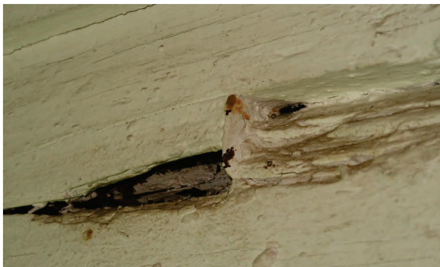
Figur 44 Blekk i kam, vankant. foto PSP
