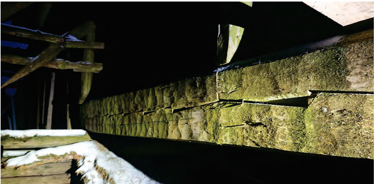
Figur 52 Kammadrageren i det sammenraste omtådet står i vær og vind. Foto PSP
