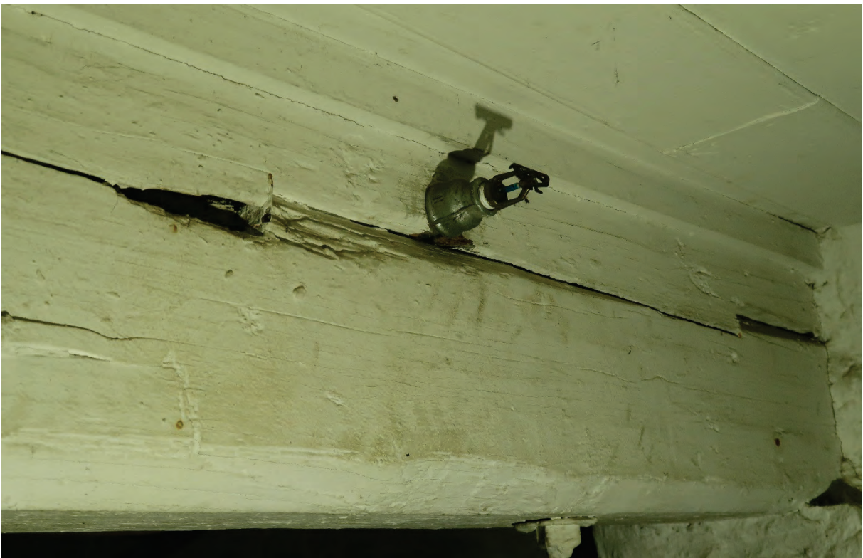
Figur 45 Blekk i kam, vankant og sprinkler, foto PSP
