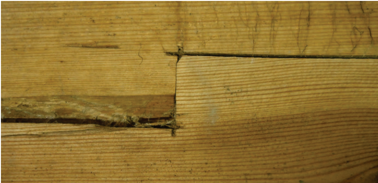
Figur 34 Stoppspor etter saga. Vankant mot kam. Fas på kam. Foto PSP
