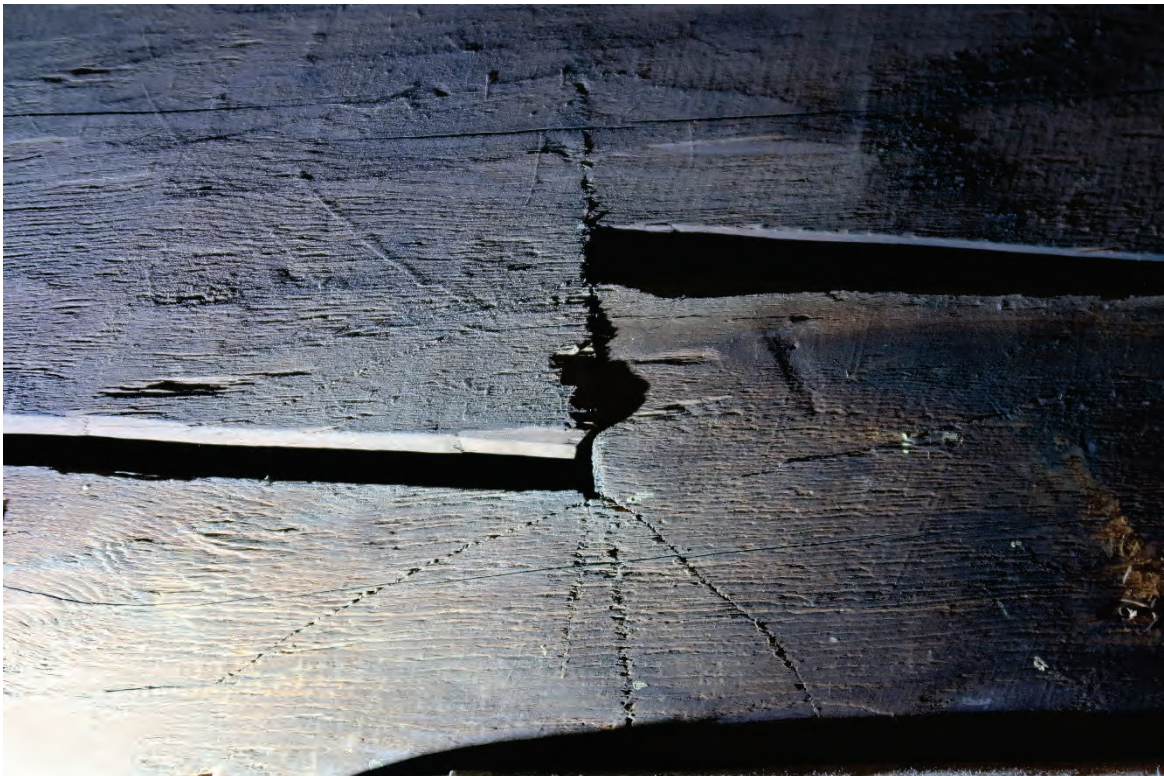
Figur 28 Verktøyspor etter merking med rissnål eller liknende. Foto PSP
