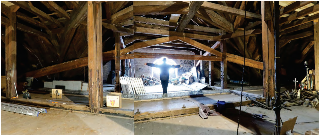
Figur 61 Sperrebindet, satt sammen av to foto. Foto PSP
