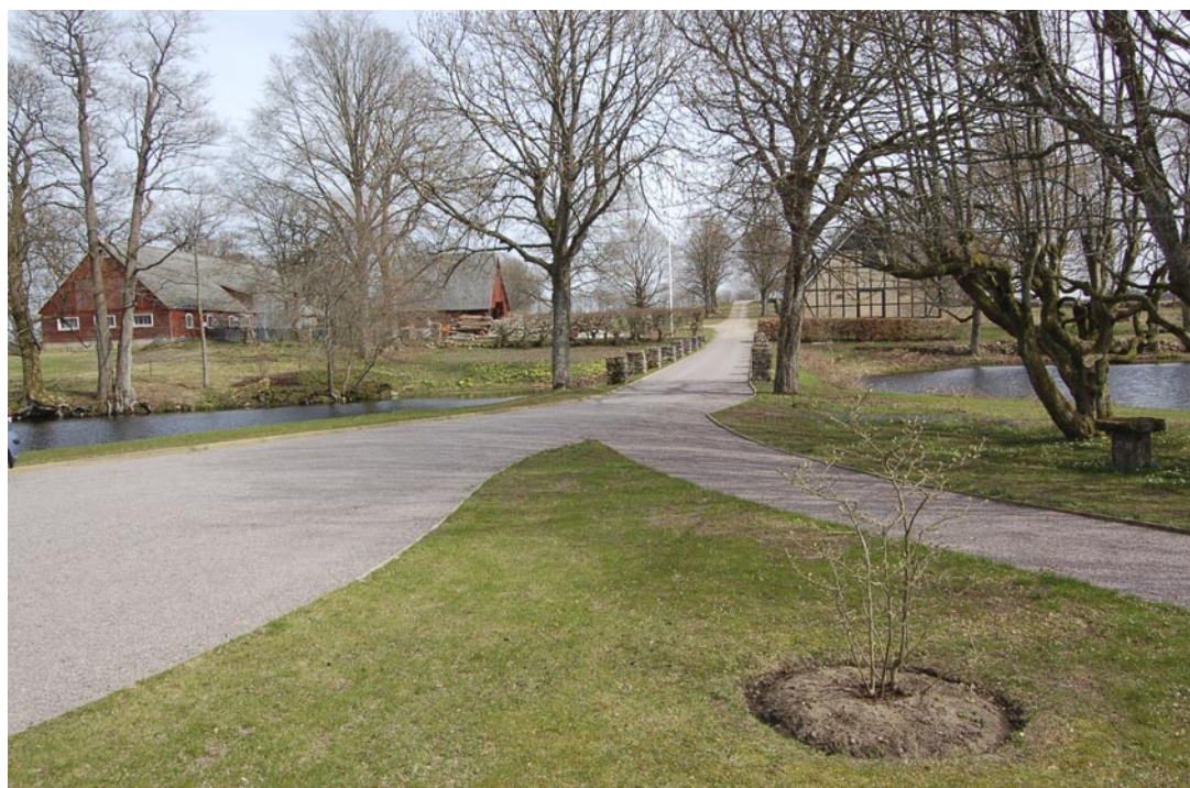
FIGUR 2. Ekonomigården mot öster. Den består av två parallella längor, koladugården i norr (till vänster på bilden) häststallet i söder (till höger på bilden) och trösklogen i mitten. Av den senare återstår bara en tredjedel. Alla byggnaderna är i skiftesverk och strukna med faluröd färg utom stallängans västra gavel som är i korsvirke med tegel. Alla tak utgörs av korrugerad eternit. Foto Ulrich Lange.
