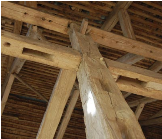
FIGUR 13. Stolpe i östra högremsväggen med remstycke och löshultar, samt stickbjälke. Här ser man hålen efter trågallret som har använts för lagring av sädesskärvar. Här finns snedhuggna tapphål, som ger indikation av återanvändning av timmer, eftersom det inte finns motsvarande tapphål på stolpen. Man ser också att kilarna i stickbjälkens genomgående tapp har överbelastats av dragkrafter, knäckts och därvid förlorat en del av sin funktion. Foto Ulrik Hjort Lassen.
