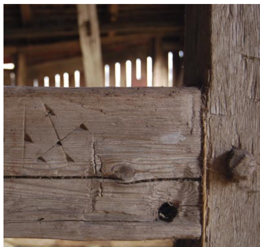
FIGUR 14. På det inre stolpverkets västra och östra sida finns inhuggna romerska siffror utstyrda med flaggor. Här ser man tydligt att löshulten är i furu medan stolpen är i ek, samt formen på ekdymlingen som är islagen från samma sida som märkningen. Foto Ulrik Hjort Lassen.
