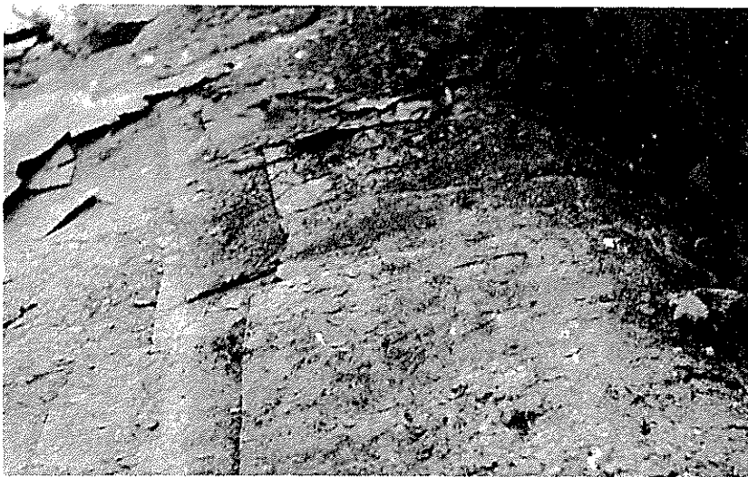
Fra taket på Nordre Jørstad i Fåberg. Torv og never er fjernet, og en ser borkeplatene på mønet. Foto: De Sandvigske Samlinger.
