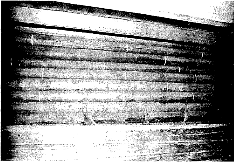
Tømmeret er sevjebarket, merkene etter borkeflåingen er krittet opp for fotografering. Fra grønstabburet på Gile. Foto: Toten Museum.
