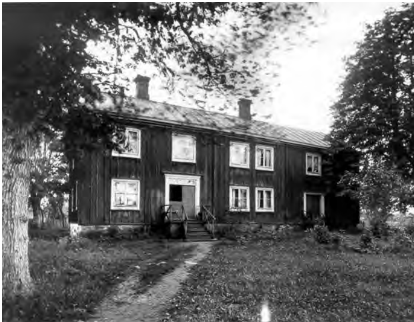
FÅLABODA, URSHULTS SOCKEN, SMÅLAND. Gårdens bostadshus i två våningar har papptak som är lagt med trekantslister. I nederkant är listens lagd som en fotränna på ett plåttak.
