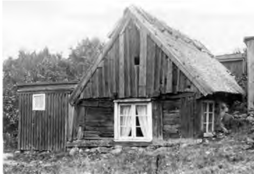
YSANDE SOCKEN, BLEKINGE. Huset som ser ut att knappt hålla ihop är byggt med stolpar och skift. Att döma av det tomma urtaget i den vänstra stolpen kan man misstänka att detta enkla bostadshus är byggt av återanvänt material. FOTO CA 1890 BLEKINGE MUSEUM.
