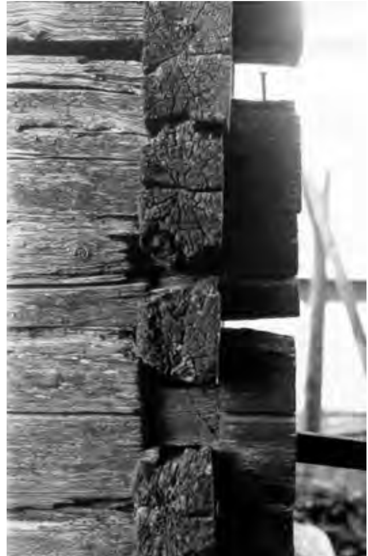
KNUTAR. Bilden till vänster är från ett bostadshus i Blekinge och bilden till höger är från fähusdelen i en lada i Småland. Båda knutarna är av samma typ som c i föregående bild. Timret i bilden till vänster är delat i mitten med såg. I den högra bilden är väggtimret urtaget mitt i stocken. FOTO NORDISKA MUSEET.
