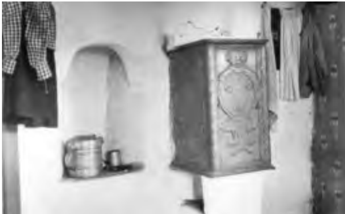
SKISS AV SPIS I STUGA I ÖRKENEDS SOCKEN, SKÅNE. (Efter Erixon S., 1947, Svensk byggnadskultur .) Eldstad med kokgruva framför bakugnen. Gruvan stängdes med luckor. I hörnet finns en lyshärd, en så kallad "lillefyr". En motsvarande lyshärd finns i bilden från Humlemåla, Ringsmåla socken, Blekinge. FOTO 1923 NORDISKA MUSEET.
