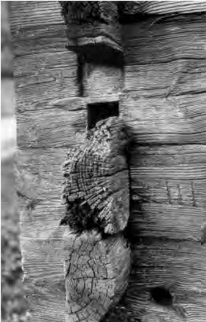
KNUTAR. Bilden till vänster är från ett bostadshus i Blekinge och bilden till höger är från fähusdelen i en lada i Småland. Båda knutarna är av samma typ som c i föregående bild. Timret i bilden till vänster är delat i mitten med såg. I den högra bilden är väggtimret urtaget mitt i stocken. FOTO NORDISKA MUSEET.
