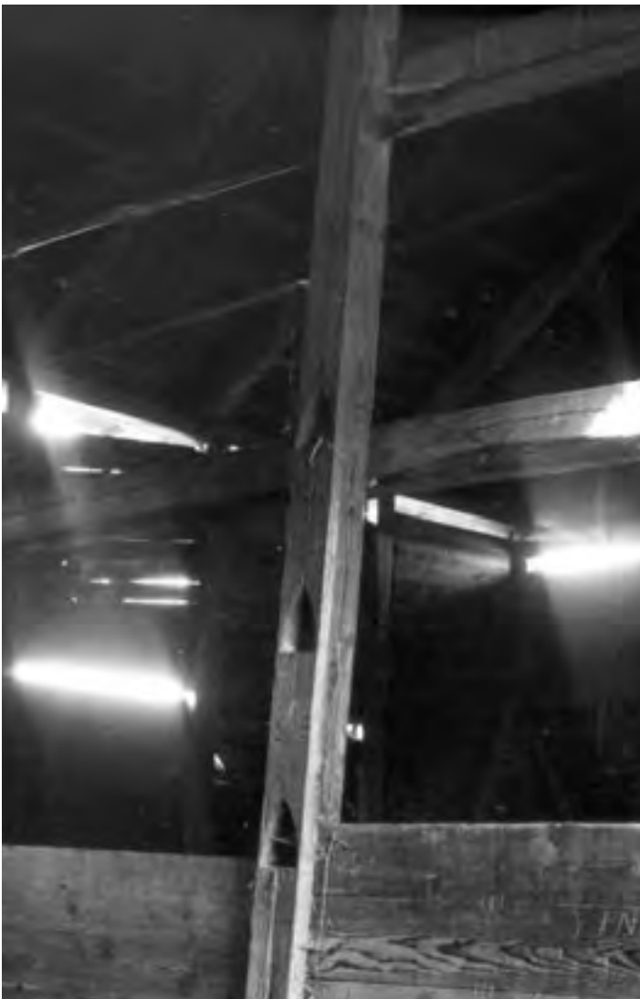
SKIFTESVERKSLADA, ASARUMS SOCKEN, BLEKINGE. Logklyvare eller logklev som stigstolpen också kallades i August Holmbergs hembygd.
