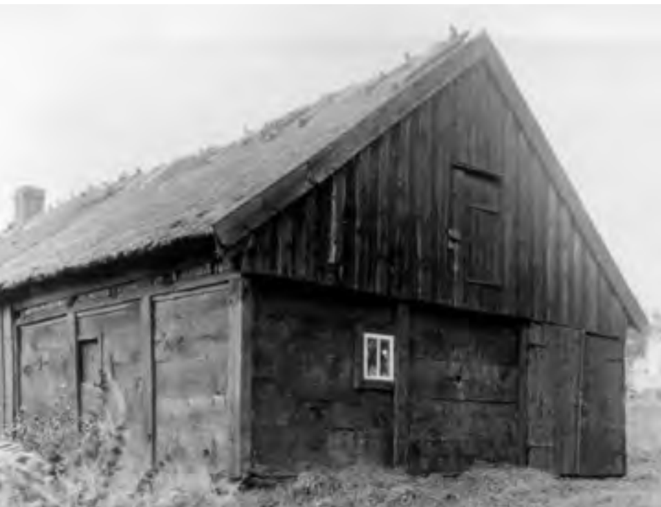
BISKORPSTORP, KVIBILLE SOCKEN, HALLAND. Skiftesverksladugård som är byggd med sågade stolpar (sannolikt kransågade). Även skiften ser ut att vara sågade. FOTO 1924 NORDISKA MUSEET.
