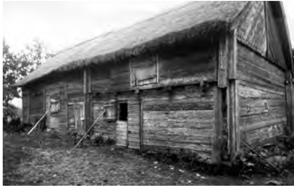
DUNSHULT, URSHULTS SOCKEN, SMÅLAND. Ladugård med timrat fähus och/eller stall. Den bortre delen med lada och loge är byggd med skiftesverk. Ovanpå stallet finns höränne eller någon typ av foderbod. På framsidan skjuter den timrade väggen ut något. Det timmer som vilar på bjälkarna har, jämfört med boden i detta kapitelns första bild, ett likartat men anspråkslösare skuret ornament. Gaveln med snedställda och fastnaglade bräder visar att timringen inte går högre upp än till vabordet. FOTO NORDISKA MUSEET.
