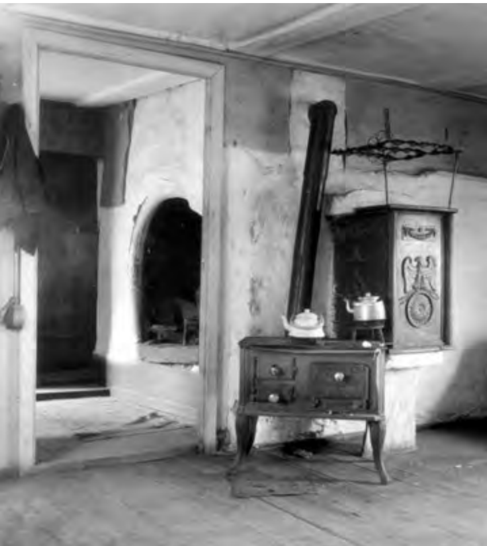
SKOMAKARBODA, HJÄRSÅS SOCKEN, SKÅNE. Järnspis vid sidan av sättugn och öppen spis (gruva med bakugn?) i rummet intill. Denna har en kraftig stenhäll som botten. Murverket vilar inte på ett valv utan på en krum stock. FOTO NORDISKA MUSEET.
