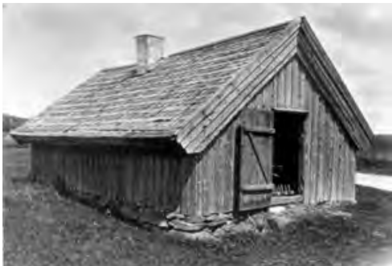
BASTU, NÅKÄLLA, FJÄRÅS SOCKEN, HALLAND. Spåntak lagt med växlande överlägg i sidled. Nocken skyddas av takhatt av brädor. Det ser ut som om spåntaket lagts ovanpå ett halmtak. FOTO NORDISKA MUSEET.
