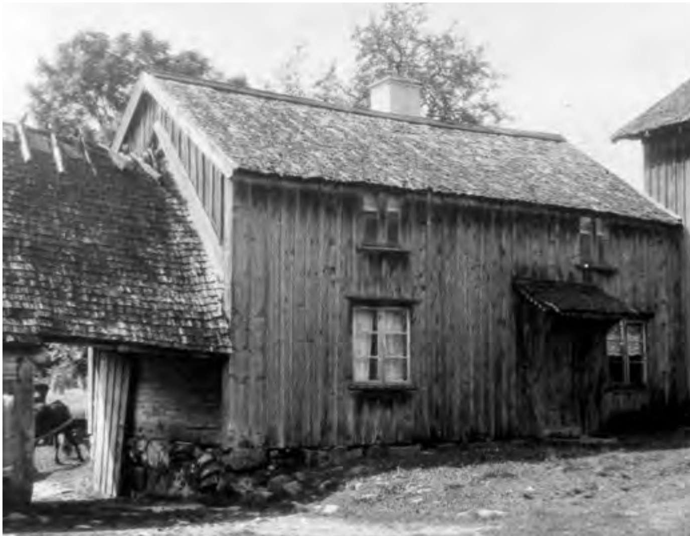
G.A. ANDERSSONS GÅRD HALSBO, DRENGSEREDS SOCKEN, HALLAND. På 1920-talet var flertalet av denna fyrbyggda gårds byggnader spåntäckta. Spåntaket på stugan i bildens mitt var omsorgsfullt lagt. Taket hade vindskidor som var gerade inock och takhatt av två brädor. På mindre viktiga byggnader användes vanligen enklare avslutningar. Den underliga utformningen av taknocken över lidret förklaras av att byggnadens andra takhalva hade halmtak med ryggträ. FOTO NORDISKA MUSEET.
