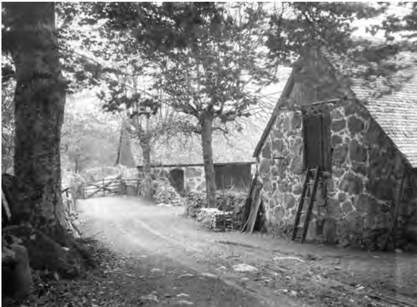
NORRA RÖHULT, JÄMSHÖGS SOCKEN, BLEKINGE. Byväg och infart till fägård med två parallellt placerade ladugårdslängor i sten, som ligger som flyglar framför bostadshuset och mangården. Enligt August Holmberg var detta byggnadssätt vanligt på de lite större gårdarna. FOTO NORDISKA MUSEET 1924.
