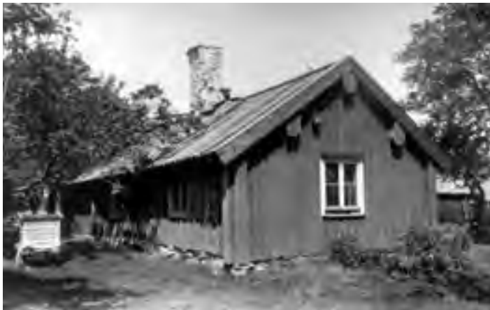
EKÖN, HINNERYDS SOCKEN, SMÅLAND. Detta brädtak är mer omsorgsfullt lagt än det i den föregående bilden. Takbrädorna på stugan i Ekön kan mycket väl ha hyvlade vattenrännor av det slag som August Holmberg skriver om. De utkragade stenarna i skorstenen visar att brädtaket ersatt ett tidigare torvtak. FOTO NORDISKA MUSEET.
