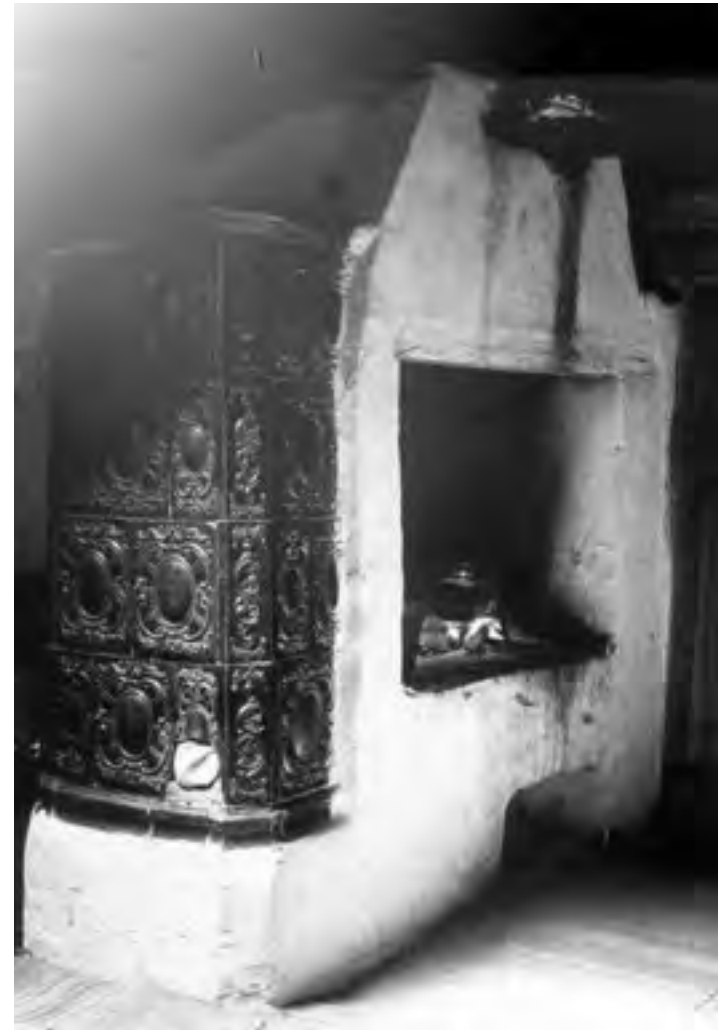
KLASTORP, TRÄSLÖVS SOCKEN, HALLAND. Kakelsatt sättugn som eldas från gruvan. FOTO 1918 NORDISKA MUSEET.
