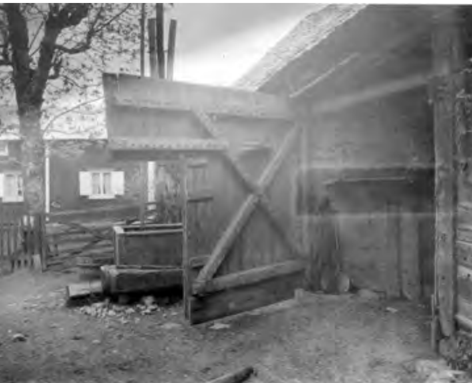
NORRA RÖHULT, JÄMSHÖGS SOCKEN, BLEKINGE. Dörr till ladugård sammanfogad med trä naglar. Enligt August Holmberg var torkhusens dörrar tillverkade med samma teknik. FOTO NORDISKA MUSEET 1924.
