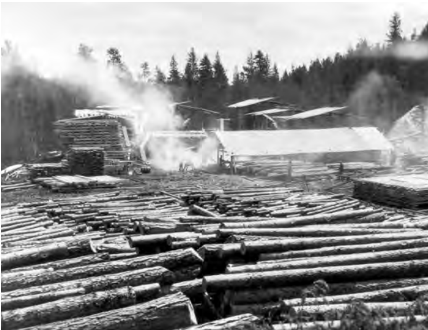
SÅGPLATS FÖR TRANSPORTABEL CIRKELSÅG. Anläggningar av detta slag ersatte de gamla vattendrivna sågarna. FOTO SVENSKA SKOGSVÅRDSFÖRENINGEN.
