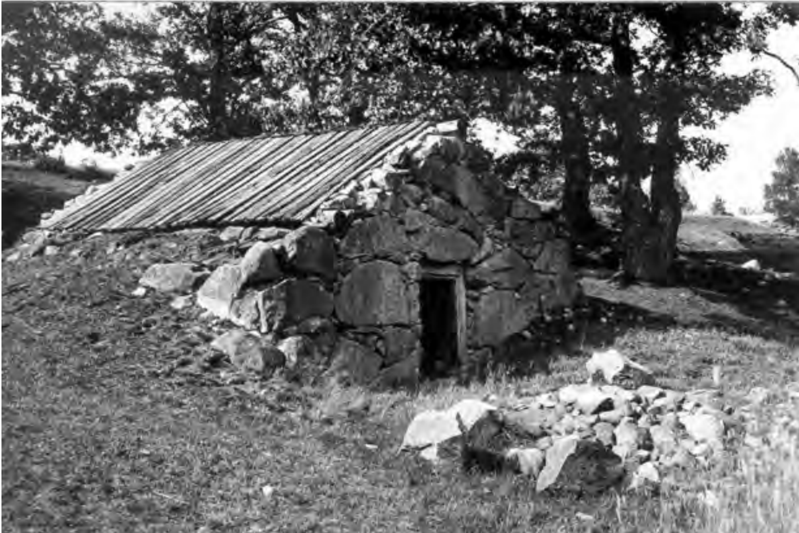
BRÄDTAK PÅ KÖLNA, HALLAND. En svaghet med den senare typen av bräddtak av klen sågat virke som inte var formstabil var att taken läckte när brädorna vred sig och det blev öppningar mellan under- och överbräda. FOTO NORDISKA MUSEET.
