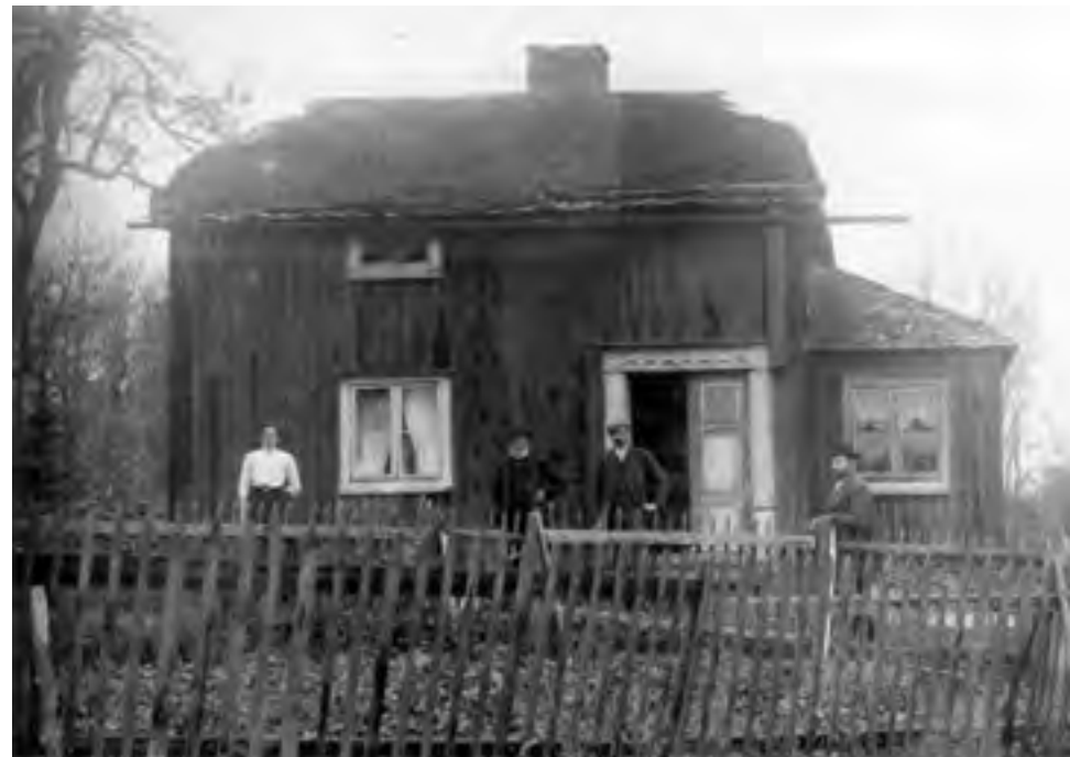
KARSTORP, URSHULTS SOCKEN, SMÅLAND. Denna korta höga stuga med valmade gavelspetsar visar att torvtaken inte enbart användes på de ålderdomliga byggnadstyperna. Mulåsen hålls här på plats av sex takkrokar. Under den utstickande nävern i takfoten ligger sannolikt droppspån. Nocken skyddas av brädor och väggarna skyddas från takvattnet av en hängränna urhuggen ur en klen stam. FOTO NORDISKA MUSEET.
