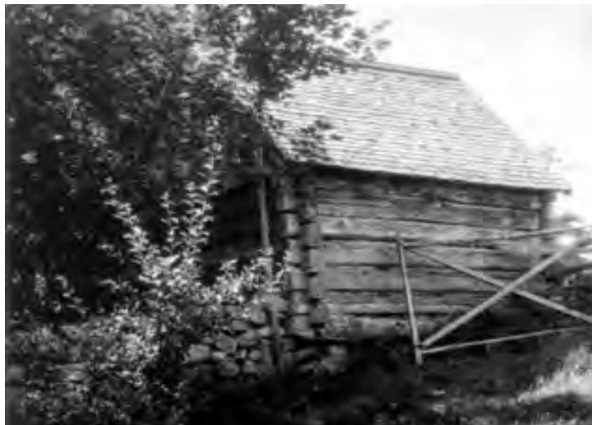
ÄNGSLADA VID SJÖN HALEN, JÄMSHÖGS SOCKEN, BLEKINGE. Ladan är byggd som en hölada utan timrade gavlar, men huset kan mycket väl haft en annan funktion tidigare. Timret i gavel- och långväggarna är nämligen ordentligt skrätt (dock inte så mycket att vankanten helt försvunnit) och urtaget på undersidan i den nedersta stocken visar att detta inte varit fottimmer från början. Av knutskårans storlek och placering kan man se att timringen är gjord med dubbelhaksknut som man normalt använde i bostadshus eller andra mera påkostade byggnader. Det är alltså möjligt att byggnaden kan ha stått på en gård och att den med tiden flyttats ut i markerna. FOTO NORDISKA MUSEET 1933.
