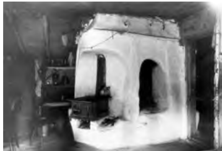
DUNSMÅLA, URSHULTS SOCKEN, SMÅLAND. Köksspis med välvd kupa som försetts med järnspis. Till höger gruva och bakugn. Den öppna spisen och gruvan har olika spjäll. I dörröppningen skymtar den öppna spisen i rummet (se även bild på sid 142 som visar spisen i rummet). FOTO NORDISKA MUSEET.
