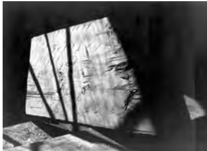
TIDERSRUMS KYRKA, ÖSTERGÖTLAND. Spräckt bräda från 1260-talet, ca 30 cm bred och 2 cm tjock. Spräckspår visar att den kilats ut. Med yxa har den grova ytan sedan jämnats till. I kyrkan finns närmare 300 kvadratmeter klädning på tak och gavlar av detta slag. FOTO PETER SJÖMAR.
