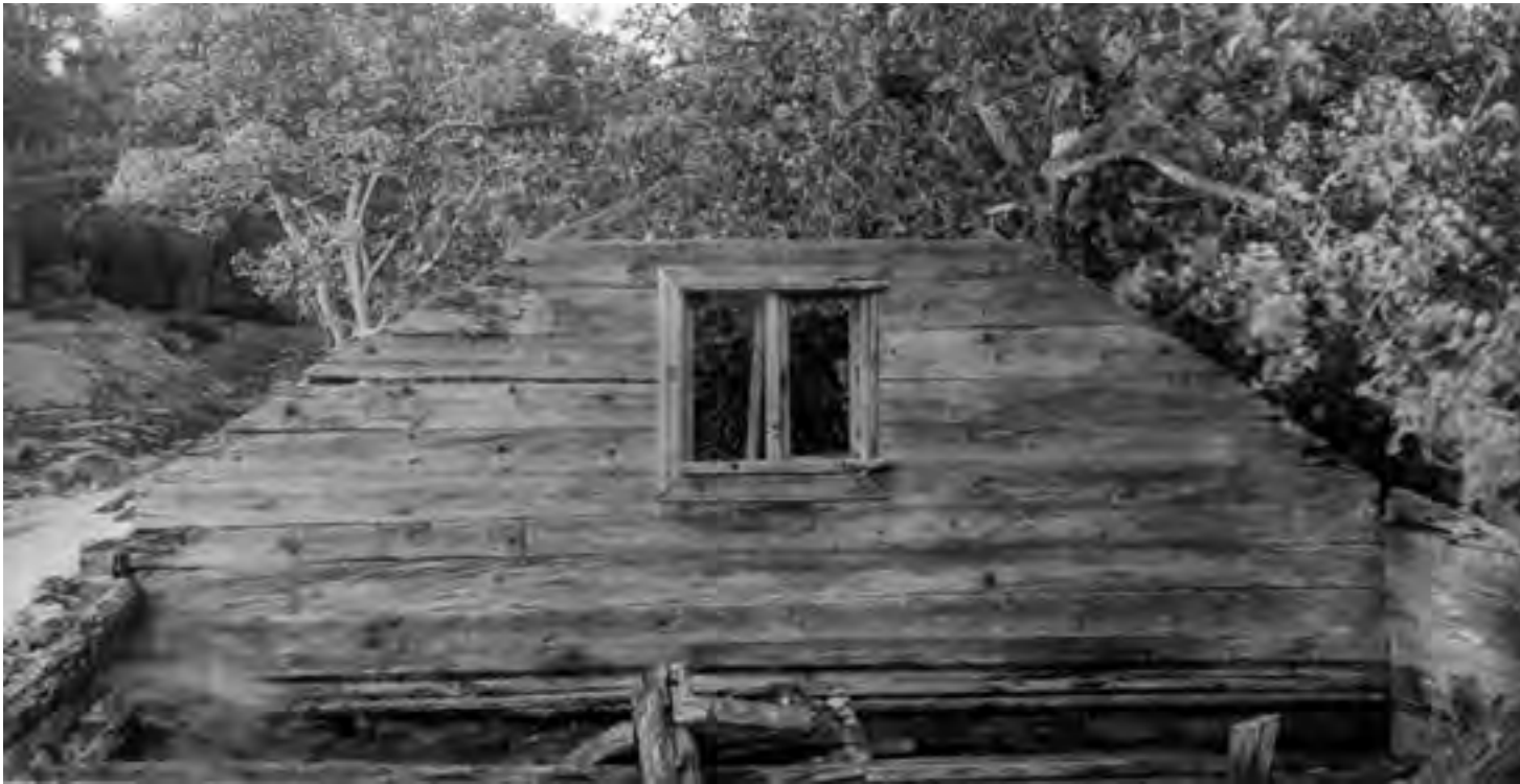
GAVELSPETS I EN GAMMAL STUGA I SKALLMÖTE, JÄMSHÖGS SOCKEN, BLEKINGE. Spanten är fastsatt med trä-naglar till gaveltimret vilket gjort att det bildats springor mellan väggstockarna. FOTO 1933 NORDISKA MUSEET.
