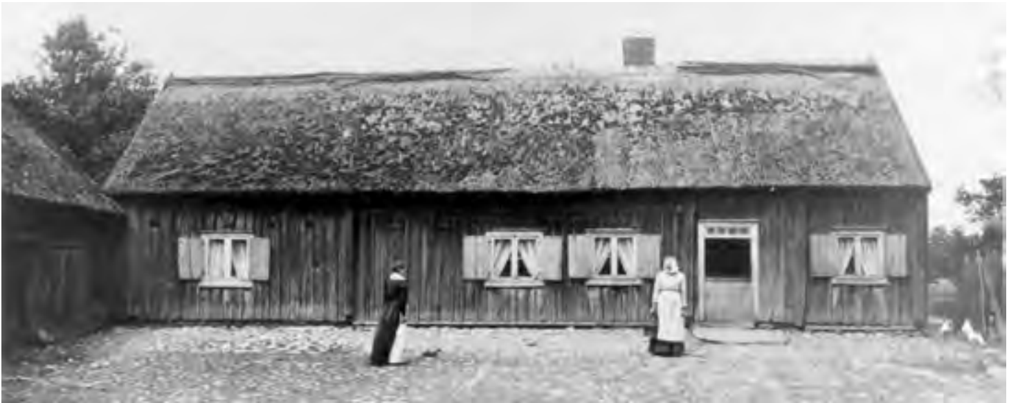
BONINGSHUS I HÖRBY, BLEKINGE. Jämfört med stugan ovan är detta halmtaks nock täckt med takhuv av brädor. FOTO 1919 BLEKINGE MUSEUM.
