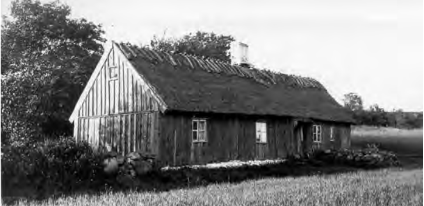
GLOSTORP, VESSINGE SOCKEN, HALLAND. Halmtaket på stugan har ryggträ, breda vindskidor men inget utskjut i gaveln. FOTO NORDISKA MUSEET.
