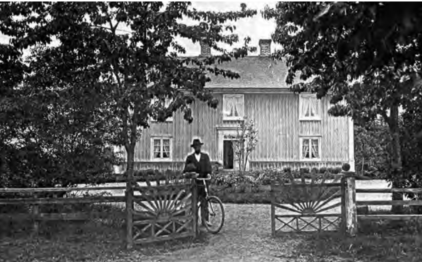
BOSTADSHUS I URSHULTS SOCKEN, SMÅLAND. Spån, främst hyvlade, blev det material som ersatte näver, torv och halm, men de tidigare taktypernas isolering gick man då miste om. Detta gjorde dock inte så mycket för när bostadshusen blev så stora att de byggdes med vind (det vill säga med innertak) kunde isoleringen placeras i det övre bjälklaget. De släta, jämna, tunna och grå spåntaken gav husen nytt utseende som säkert ansågs passande till de nya ljusa fasadfärgerna som kom på sent 1800-tal. FOTO SMÅLANDS MUSEUM.
