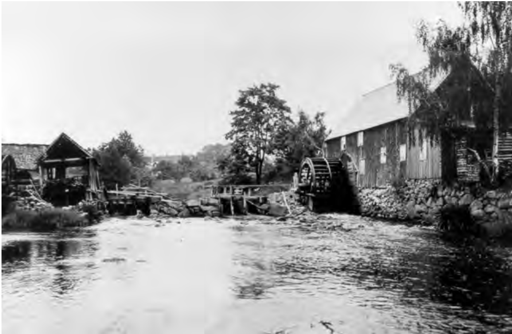
HOLJEÅN, JÄMSHÖGS SOCKEN, BLEKINGE. Vid detta fall ligger två sågar eller kvarnar med dubbla vattenhjul. I bildens vänstra del syns resterna av vad som har varit ett såghus av det enkla slag som Holmberg skriver om. FOTO 1918 NORDISKA MUSEET.
