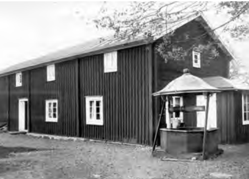
DANNEMARK, RINGSMÅLA SOCKEN, BLEKINGE. Både den långa stugan i två plan och brunnskaret är timrade. Karet är byggt på precis det sätt som August Holmberg beskrev med en fyrkantig fot och en åttkantig överdel. De fyra spetsarna i foten är täckta med plank. FOTO 1927 NORDISKA MUSEET.
