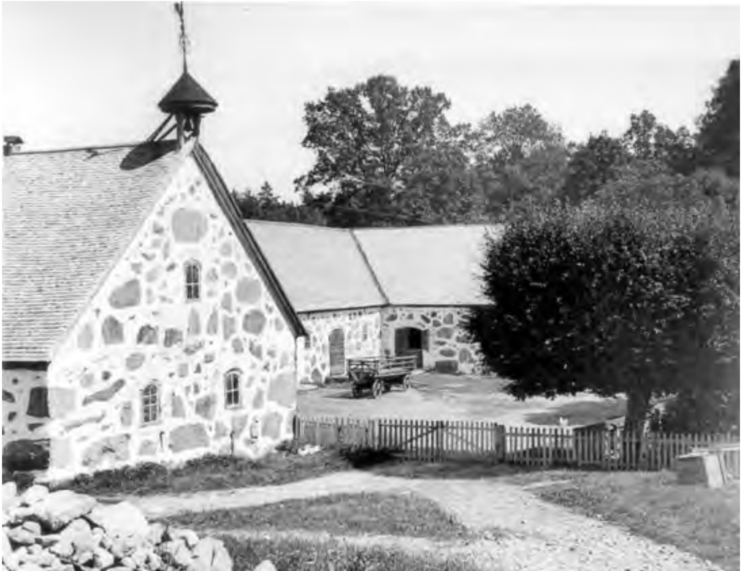
BAGGEBODA, JÄMSHÖGS SOCKEN, BLEKINGE. Spåntak var i jämförelse med torvtak betydligt lättare vilket var en fördel när man byggde tak på de stora ladugårdar som blev vanliga under sent 1800-tal. FOTO NORDISKA MUSEET.
