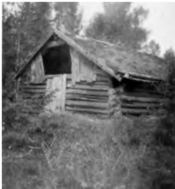
ÄNGSLADA, RÅGLANDA, HÄRLUNDA SOCKEN, SMÅLAND. Ladan är byggd med rundtimmer med brädklädda gavlar i stället för timrade gavlar på det sätt som August Holmberg beskriver. Torvtaket bärs av kraftiga sparrar i gavlarna (saxar) ochnockås. Mulåsen utgörs av en rund stock. Denna hålls på plats av takkrokar.
