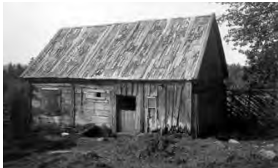
GRANET, HINNERYDS SOCKEN, SMÅLAND. Många tak såg antagligen ut som det på denna lilla ladugård. Taken var lagade med bakar och spån av olika typ och ålder. FOTO NORDISKA MUSEET.
