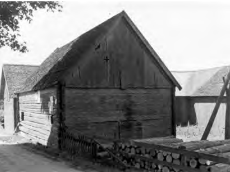
TIMRAT FÄHUS, VASHULTS SOCKEN, SMÅLAND. Taket är rest på spant eftersom gaveln är klädd med brädor. Brädorna sitter fastsatta med tränaglar (dubbar). De korsformiga öppningarna ventilerar skullen. FOTO NORDISKA MUSEET.
