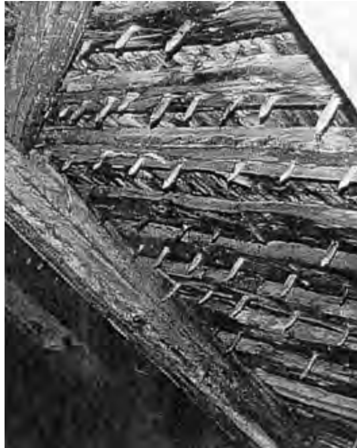
ÖRNANÄS, ÖRKENEDS SOCKEN, SKÅNE. Hyvlad spån på huggen läkt. I läkten sitter pinnarna kvar från ett äldre tak vars spånor var spräckta. Enligt August Holmberg hade denna typ av spån ”... mycket gamla anor, de fanns här och där i min barndom (1860) ... Huggen spån bestod av både fur och gran, dock endast av kvistfri gran. Spån av ek lär icke ha använts till tak å privathus, åtminstone ej i våra orter ... alla sådana tak som pålades före 1850-talet här på landsbygden fästades ... med pinnar ... I medio av 1870-talet då hyvlad spån började läggas på taken kom också 2 tums klippspik i handeln så att man fick något annat än pinnar att fästa dem med.” FOTO PAUL HANSSON.
