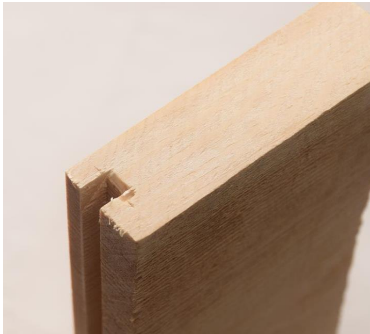
Figur 28: Biletet syner øvrekanten av eit bord med not. Legg merke til sporet etter stemjernet som er nytta til avfasinga.
