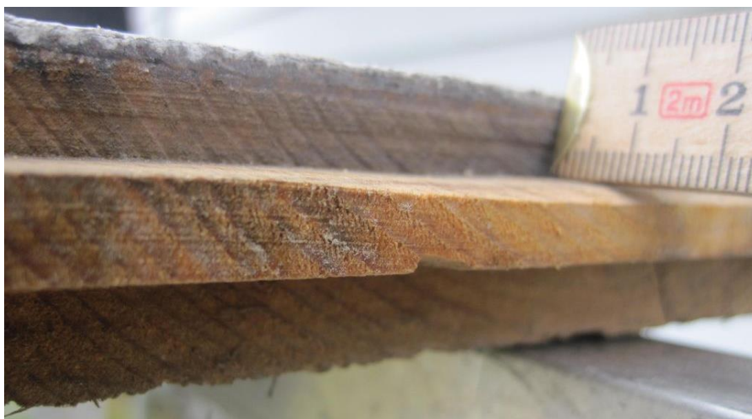
Figur 24: Biletet syner sagføringa ved ytre platt og skivinga etter ei høveltann, noko diagonalt, i enden av pennen. Frå kledningen på Suldal kyrkje.
