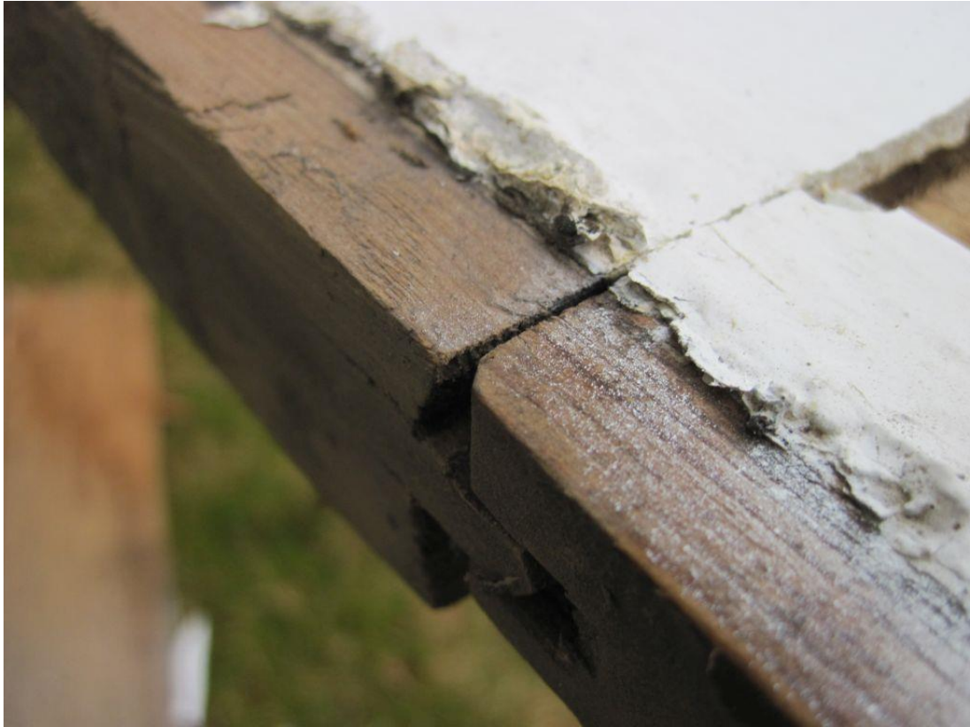
Figur 21: Biletet syner riss ved pennen og avfasing på begge plattane ved nota og i nota. Frå kledning på Suldal kyrkje.
