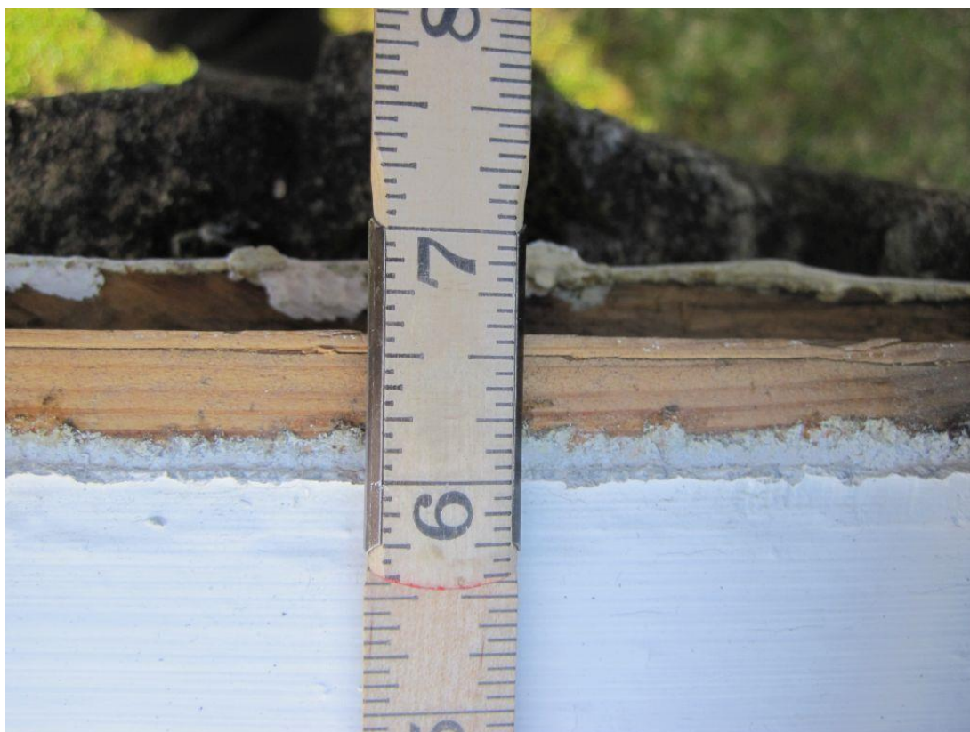
Figur 33: Døme på spor etter strekmåt-riss i øvre kant av bordet. Frå kledningen på Sand kyrkje.
