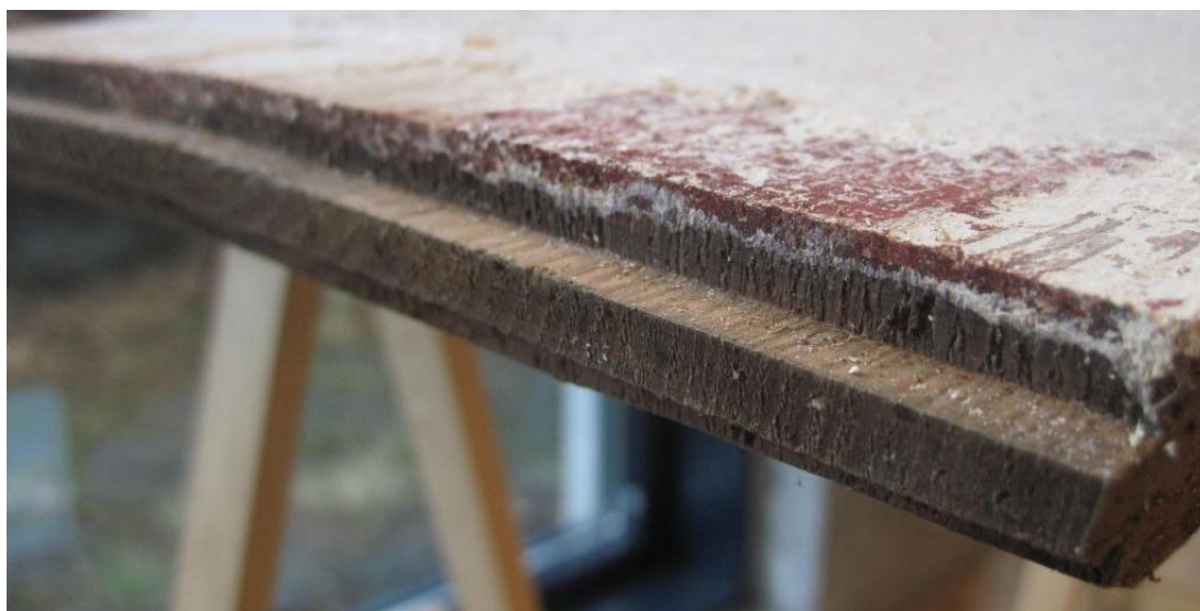
Figur 55: Biletet syner pennen i austre gavl, variant 2. Legg merke til att pennen er òg høvla i enden. Frå kledningen på Kolbeinstveit.
