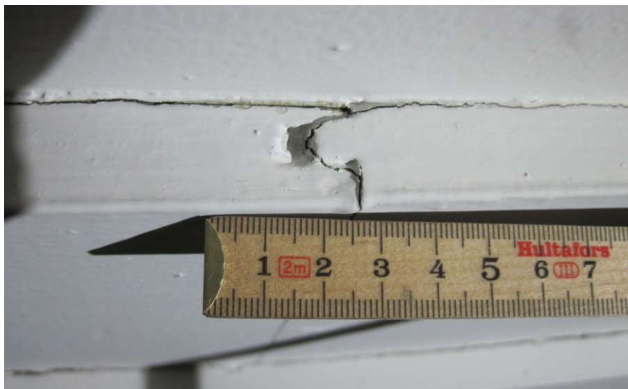
Figur 66: Biletet er frå himlingen i Sand kyrkje som i sin heilhet samsvarar med variant 2. Legg merke til hullet ved notbotnen.
