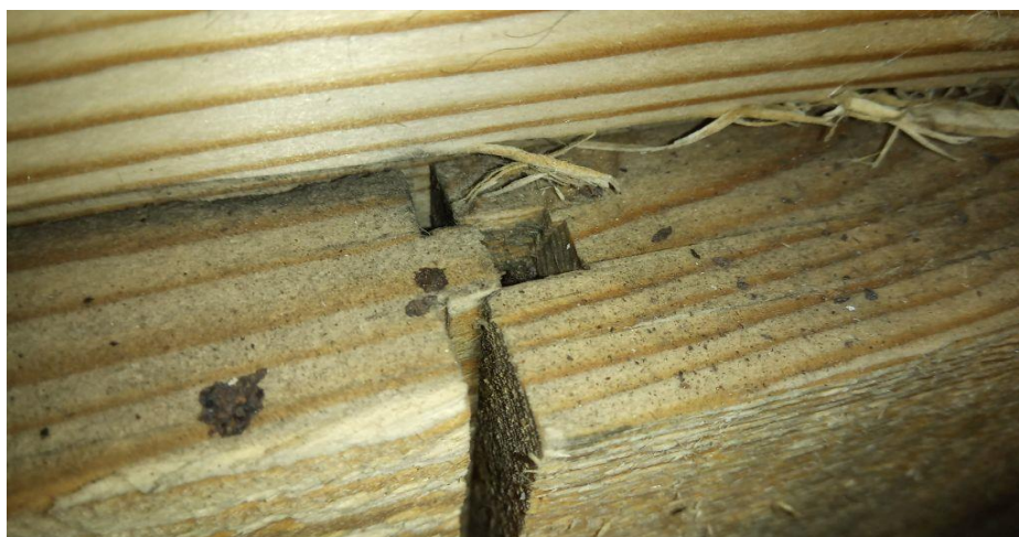
Figur 53: Biletet syner innsida av kledningen i eit sjøhus. Samsvarar med variant 1. Pennen måler 5mm i lengda og er 9mm tjukk. Den er plassert 9mm frå framsida (ytre platte). Frå kledningen på Holmen 17, 4280 SKUDENESHAVN
