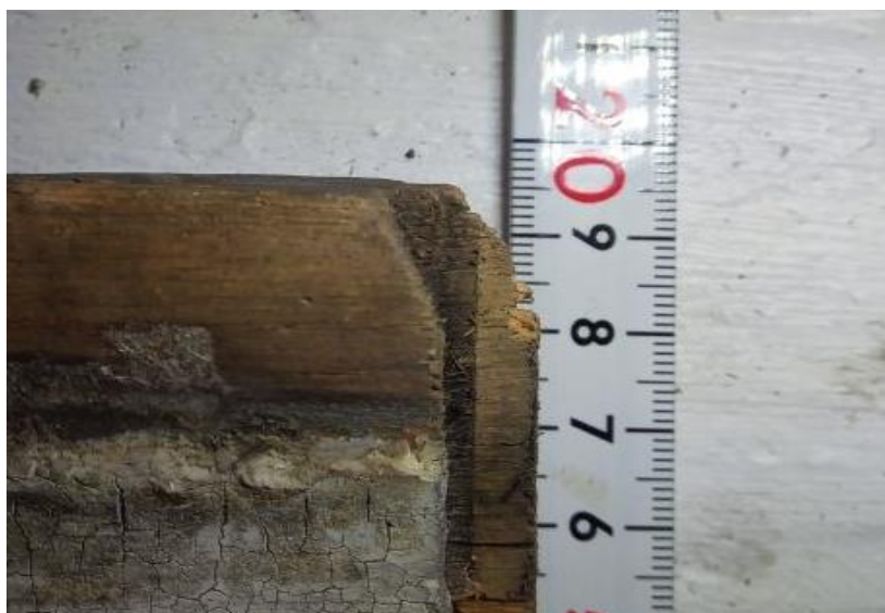
Figur 39: Avfasing i øvre hjørne. Lausfunn frå tårnet på Sand kyrkje.
