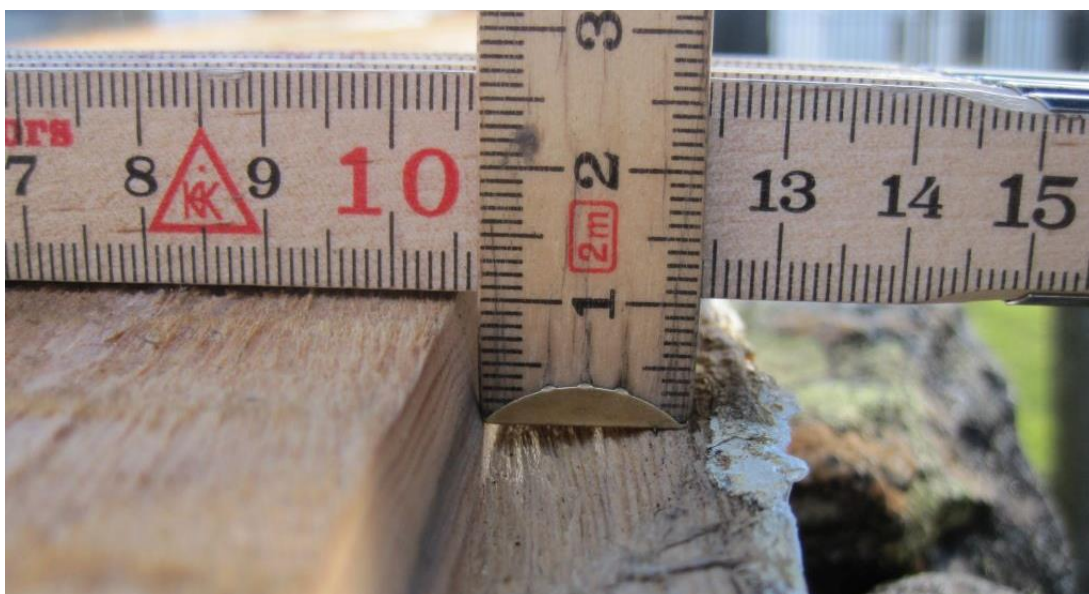
Figur 38: Illustrasjon på hvor mye flatene i falsen kan være ute av vinkel. Frå kledningen på Sand kyrkje.
