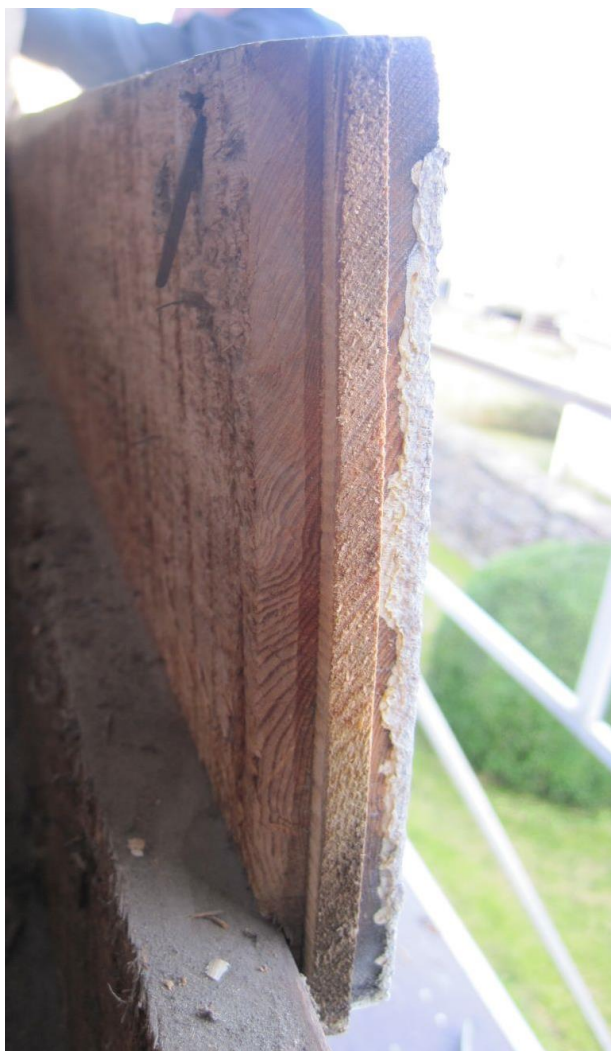
Figur 48: Døme på variant 3 i veggen. Frå kledningen på Sand kyrkje.
