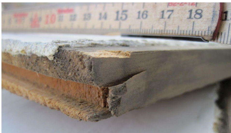
Figur 41: Utriving oppe på not. Frå kledningen på Sand kyrkje.
