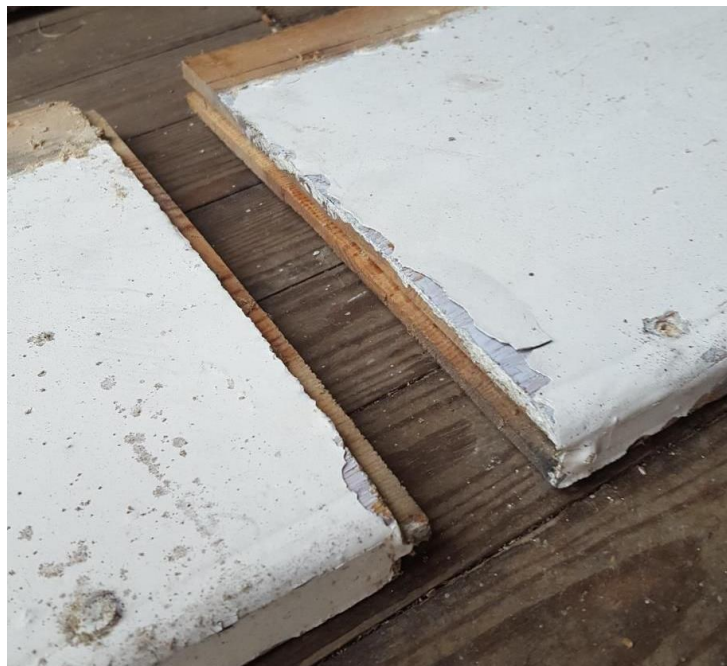
Figur 60: Variant 2 på Tysnes. Kledning frå Stora Gjersvik 2, 5680 TYSNES Fotograf: Johannes Særsten
