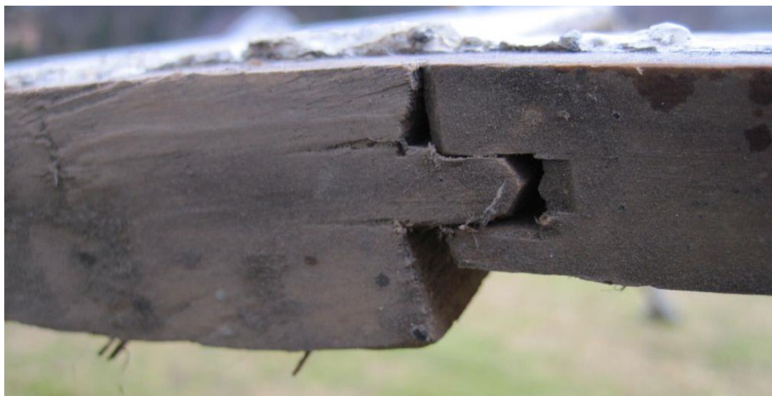
Figur 23: Biletet syner skråskjeringa av plattane ved pennen, strekmåtriss, og at det er saga litt for djupt i høve risset ved ytre platte. Frå kledning på Suldal kyrkje.
