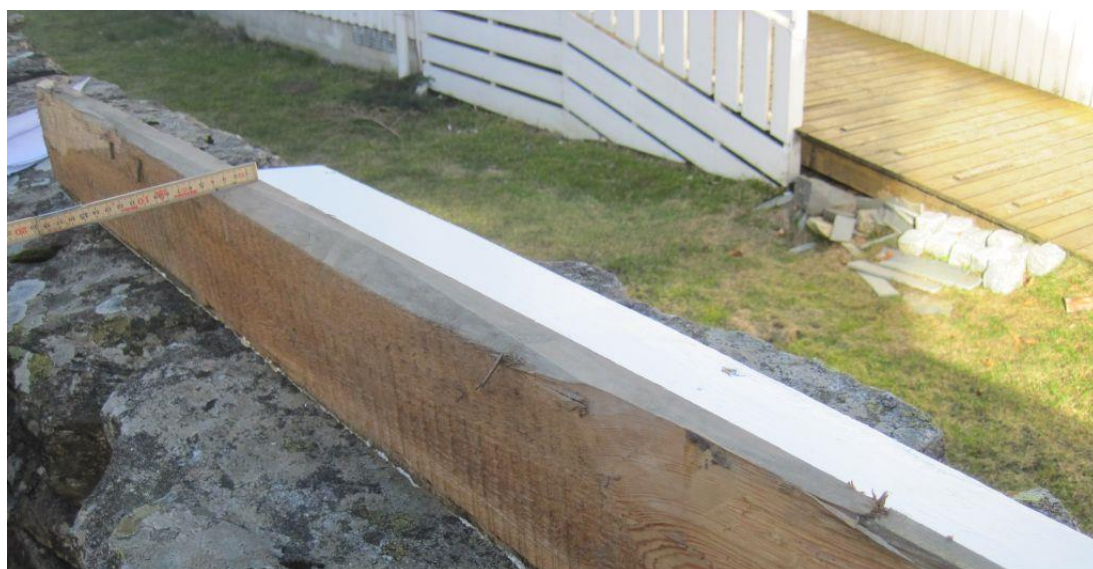
Figur 35: Døme på vankant i øvre kant av bordet. Frå kledningen på Sand kyrkje.
