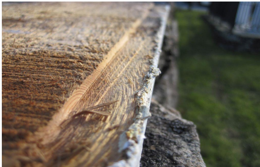
Figur 36: Tydelege spor etter skriving frå ein høvel. Frå kledningen på Sand kyrkje.
