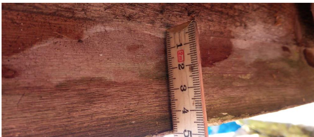
Figur 58: Biletet syner falsen på baksida av det nedste kledningsbordet. Frå kledningen på Hustveit.
