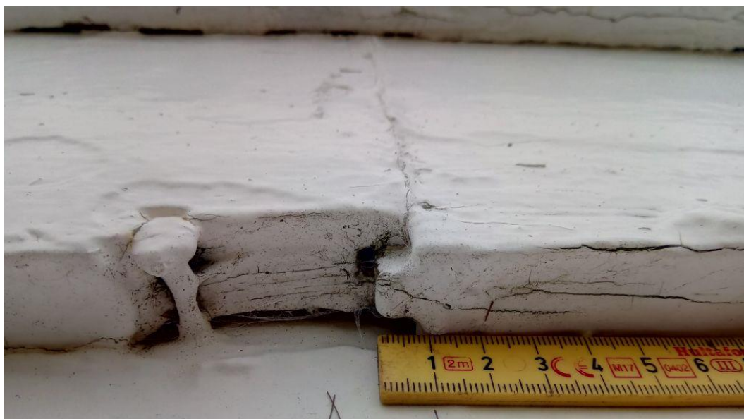
Figur 56: Biletet syner døme på endepløyinga på kledningen på Forsand kyrkje.
