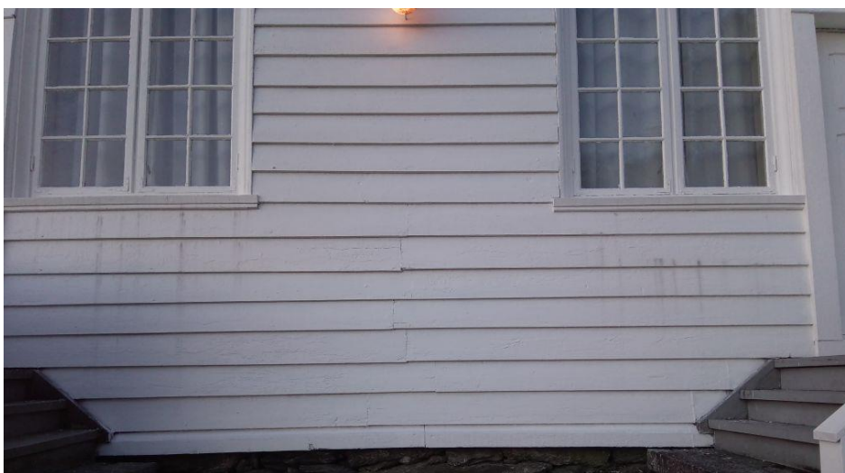
Figur 57: Biletet syner døme på at det kan skøyttast ved same spikarslaget sjølv med endepløyning. Frå Imsland kyrkje.
