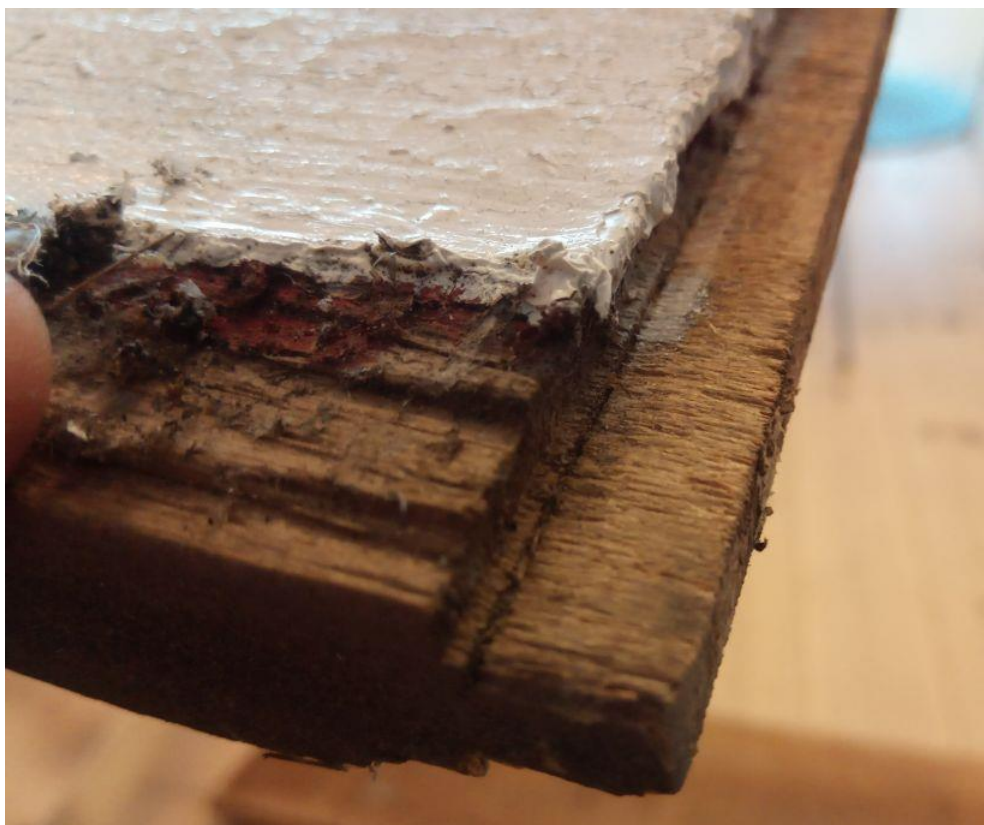
Figur 54: Døme på variant 1. Legg merke til at ytre platte er lengre inn på bordet enn sagsnittet. Frå kledningen på Kolbeinstveit.
