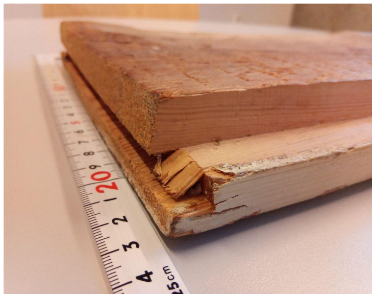
Figur 18: Høvla not i høgre ende, Suldal kyrkje. Legg merke til flisa mellom nota og falsen.
