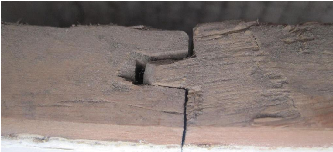
Figur 22: Biletet syner døme på not og penn utan synlege riss eller avfasing. Frå kledning på Suldal kyrkje.
