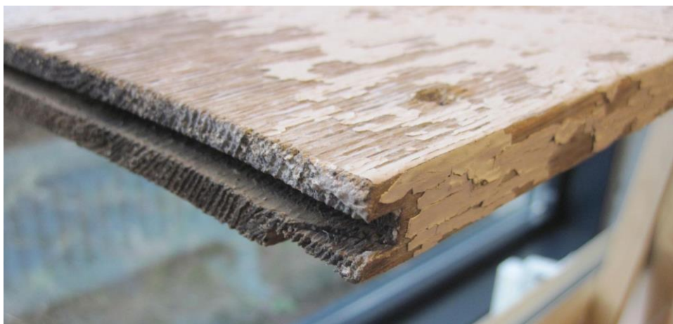
Figur 64: Enden av bordet med not. Legg merke til sporet etter avfasinga i nota som har hindra utriving i nedre kant. Frå kledningen på Stråpa.
