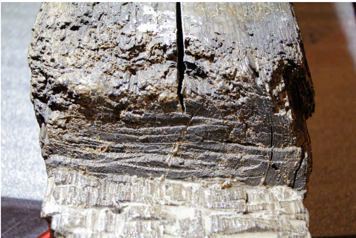
Figur 10 Her ser vi tydelige hoggespor i knuten. Det er mange hogg, kanskje med ei nokså lett øks eller lite kraft. Hoggene ligger nesten vannrett på stokken. Vi ser også at det er hogd langt gjennom marg. Bunnen i overhogget er grovt tilhogd med mange hogg rett ned. Foto Per Steinar Josteinsson Brevik
