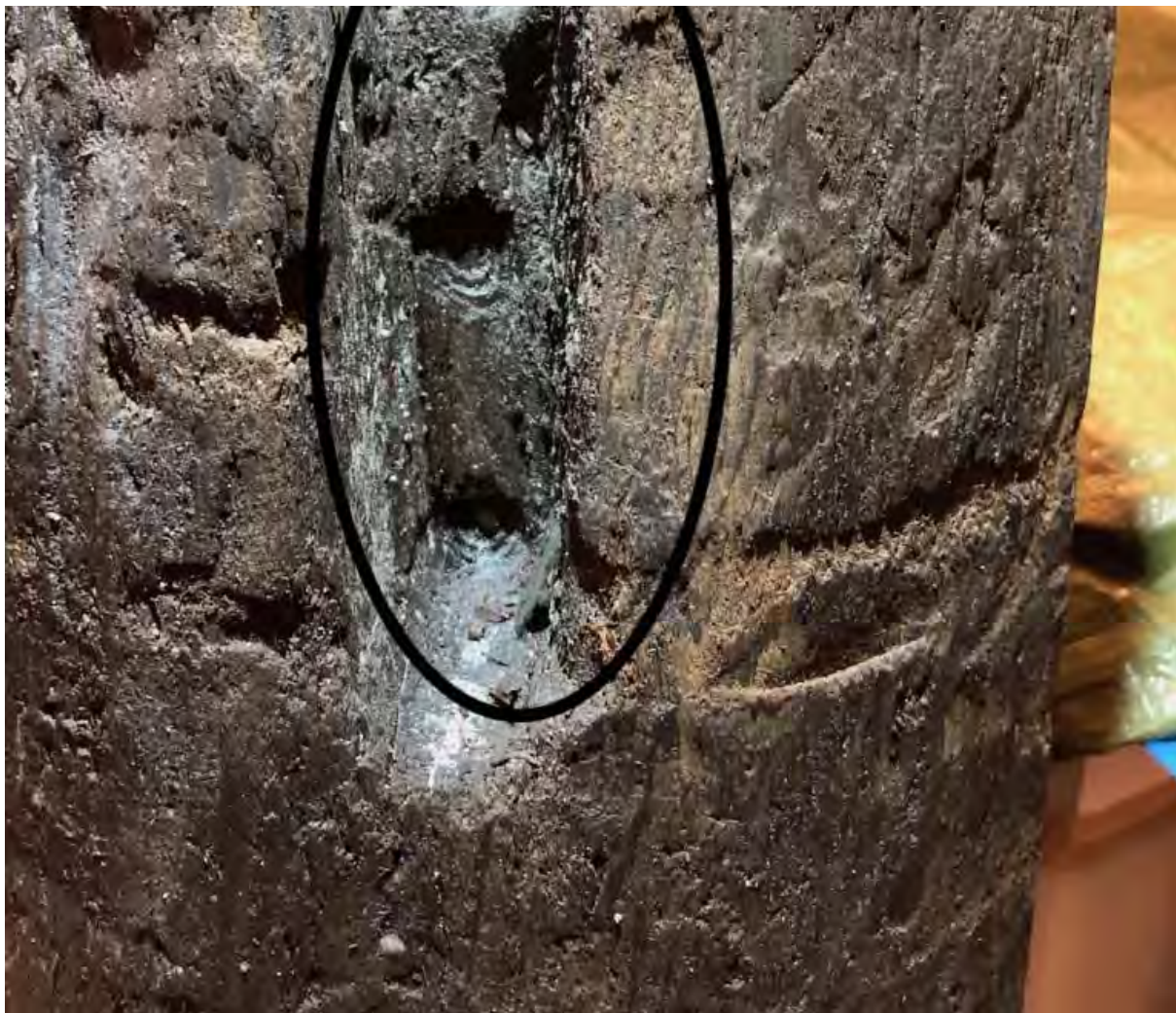
Her ser vi tydelig bruk av borr/ navar for å lage hull i sammenheng med en uttapping, kanskje en syllstokk var felt inn her. Foto K. Johansen.
