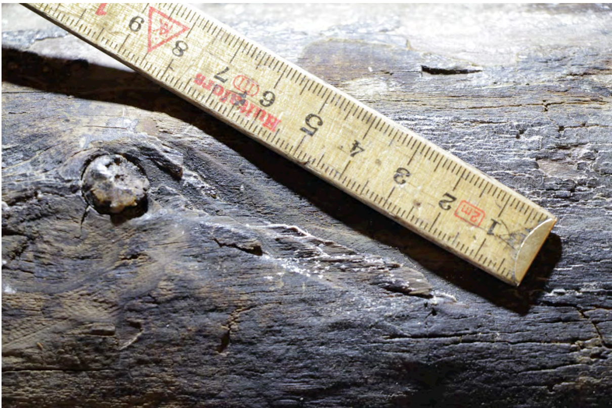
Figur 9 I forhold til detaljtegningens tolkning med i hovedsak vekt på ytre form og skraverte flater, blir den originale stokken en kilde til mange detaljer og kunnskap. Som her, hvor vi både kan se at overflaten består av yteved uten spor av barking med eggverktøy, det vil si at barken trolig er løypt, og et stoppspor etter et øksehogg der man kanskje har hogd vekk kvister. Trolig er det meste av økseeggens bredde synlig her, det vil si en eglengde på omtrent 75-80mm.
