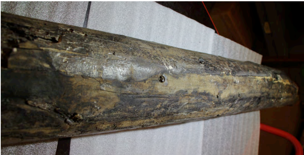
Figur 38 På undersiden av veggstokk N35270 er det ikke spor etter måsåfar eller annen bearbeiding. Om den originale stokken ikke var bevart, hadde vi aldri fått en sikker kunnskap om denne viktige informasjonen i dag. Dette er ikke med i noe av den opprinnelige dokumentasjon av stokken.
