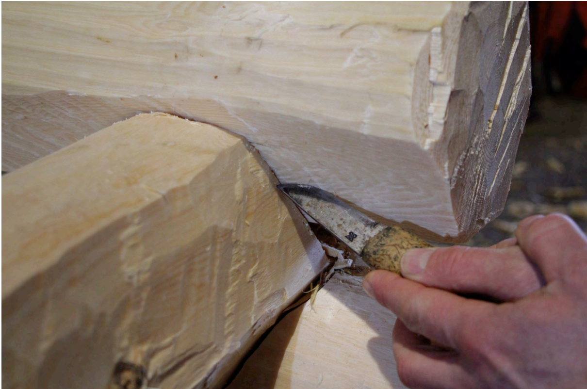
Figur 2 Det kan være utfordrende å legge ved de verktøy og metoder man har lært seg å bruke i tømringa. Men det er mulig å få gjort mye med et minimum av verktøy. Her brukes kniv til å risse for nedfelling i overhogget i vårt forsøk på rekonstruksjon av tømringa i bygning 4 fra Klemenskirkegravningen. Foto Kai Johansen
