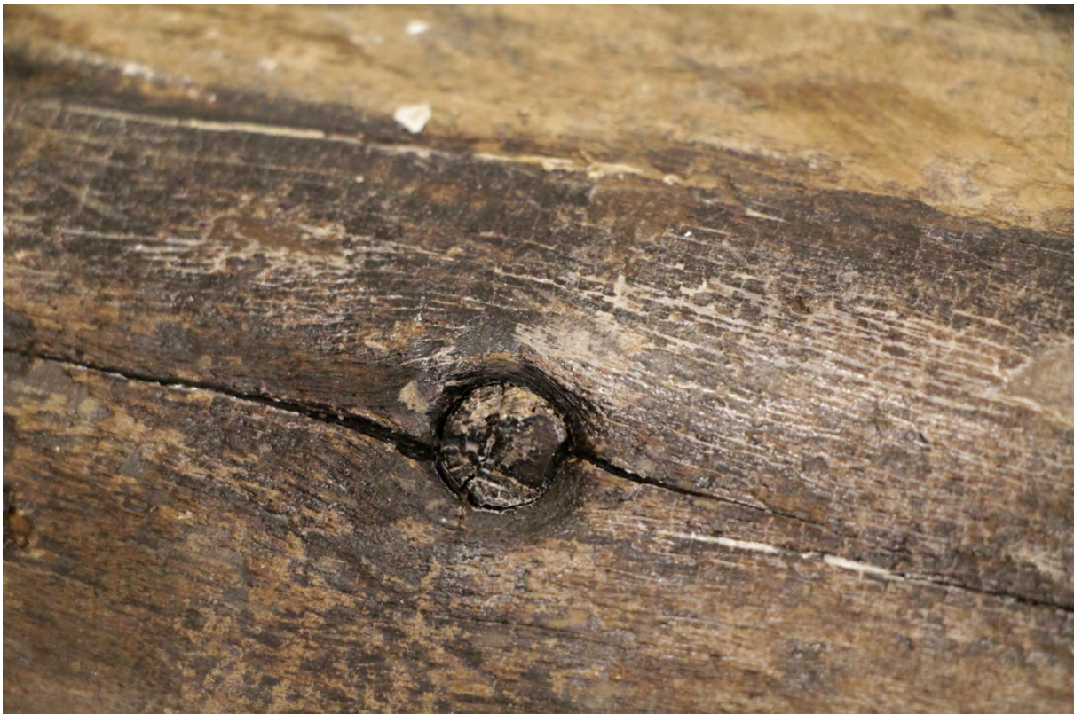
Figur 4. Informasjon fra en liten grankvist på stokk N35270. Kvisten er liten, og ser ut til å være brukket av. Det er ikke noe spor etter eggverktøy, yteveden er urørt i hele flaten omkring kvisten. Dette sier oss at barken trolig er løypt av treet som betyr at det må være felt på forsommeren, første halvdel av juni. Kvisten er typisk for små kvister vi finner langt nede på grantrær, gjerne som tørrkvist. Trolig er dette en førstestokk, fra den nederste delen av treet. Foto Per Steinar Josteinsson Brevik.
