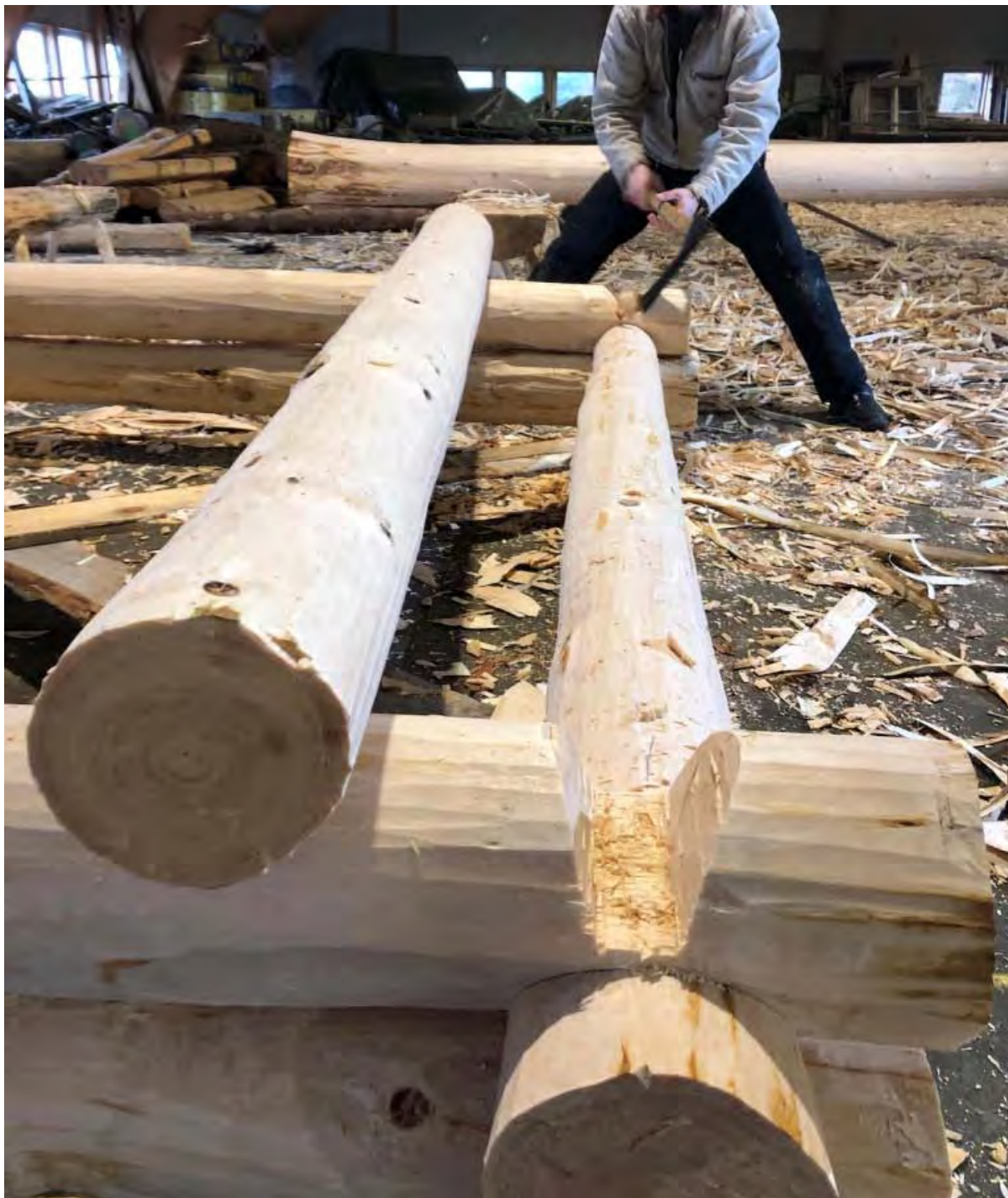
Dybden på overhugget blir etterhvert gitt av seg selv ved at det er ryggen på stokken som ligger i vegg som danner dybden på overhugget. Foto Kai Johansen
