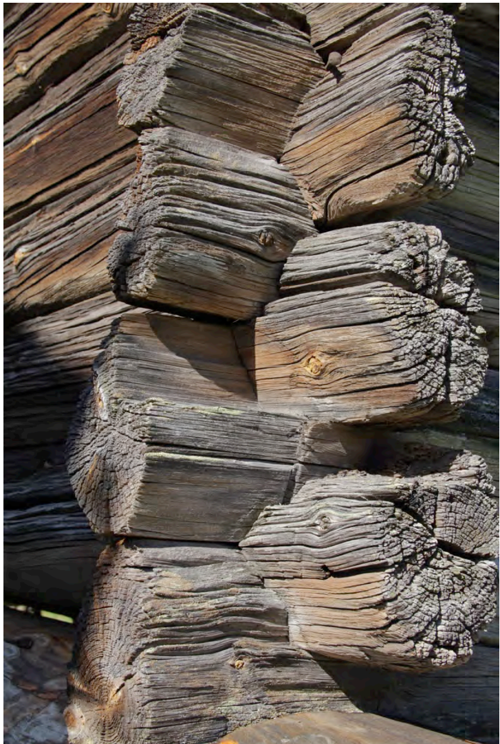
Figur 35 Nov på Kyrkhärbret i Älvdalen i Sverige. Bygget er datert 1285. Dette er i prinsippet de samme knutene som vi tømret med Björn, og det er svært lite som skiller dette fra tømringa vi finner i Trondheim i tidlig middelalder. Foto Per Steinar Josteinsson Brevik
