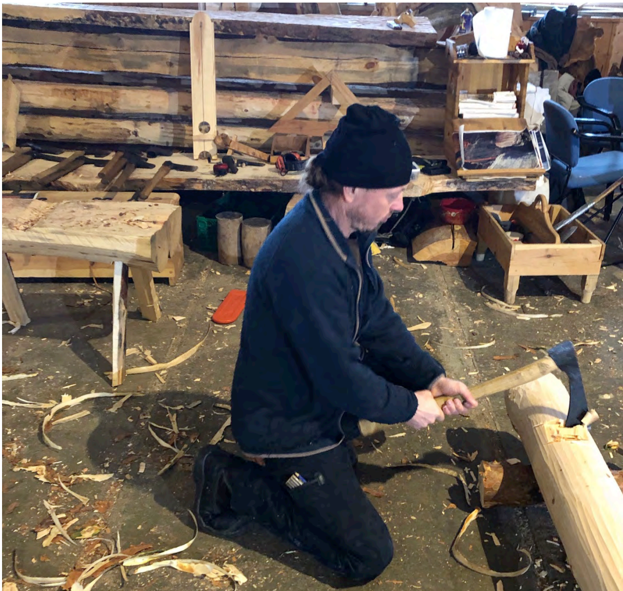
Figur 21 Per Steinar hogger ut overhogget i svilla underrekonstruksjonsforsøket. Stokken ligger lavt og han setter seg på huk for å få en bedre arbeidsstilling. Foto Kai Johansen
