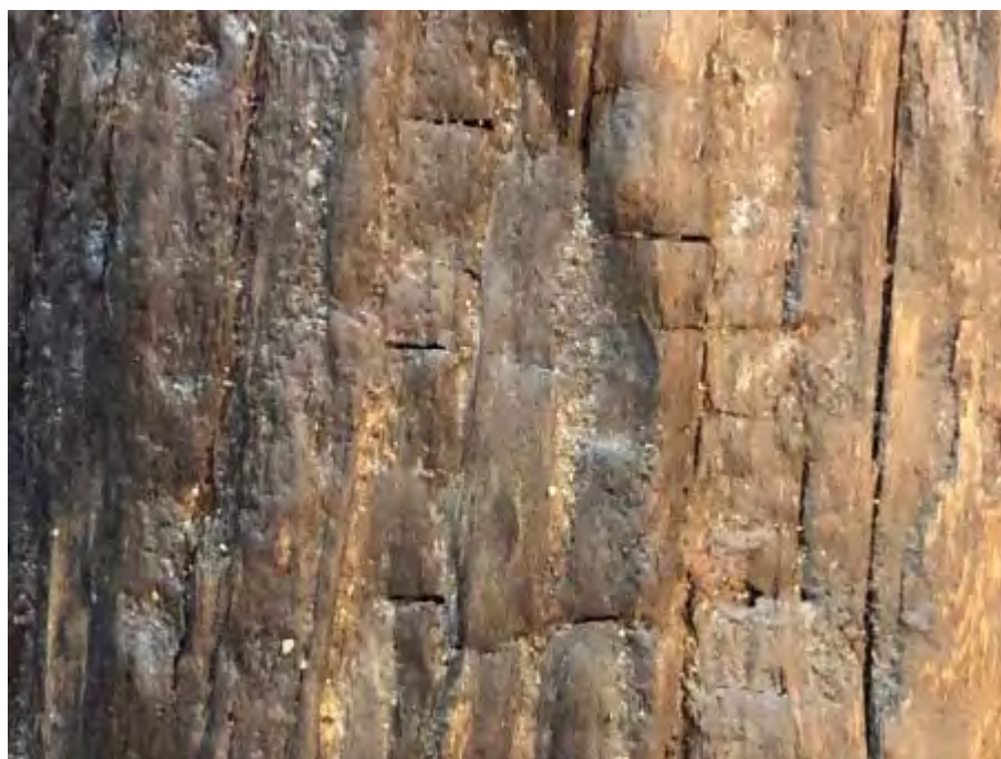
Glepphogging. Stokken var tydelig formet selv om denne delen var gravd ned i jorda når stokken var i bruk. Foto K.Johansen.
