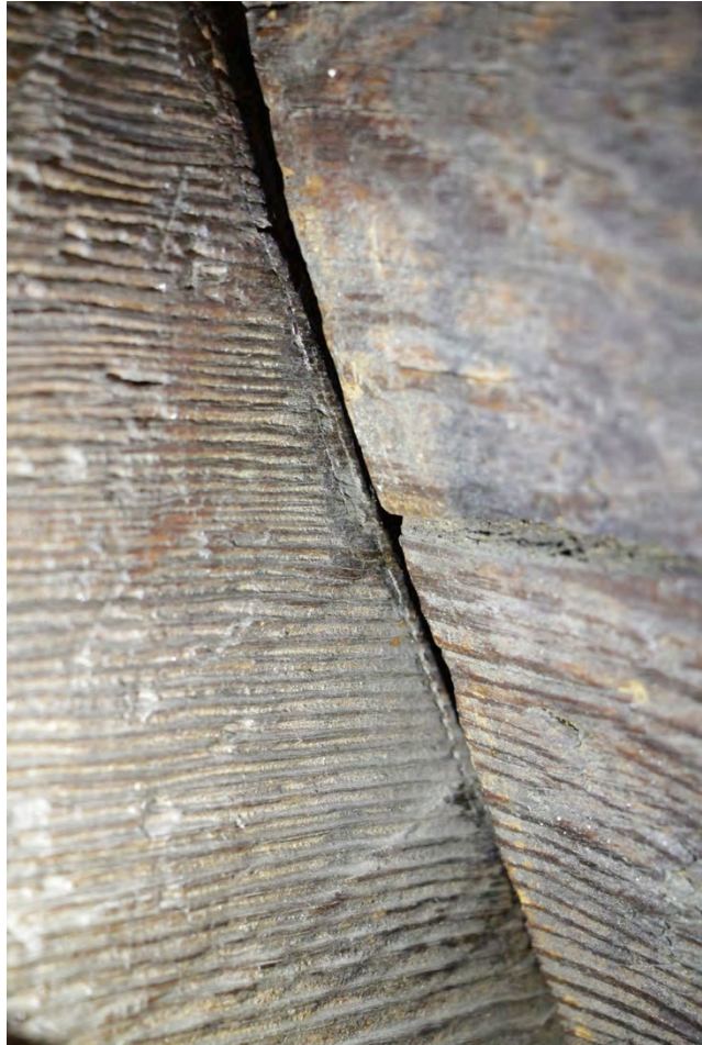
Figur 23 Spor etter merking med et spisst redskap i en knute i Uvstua fra Rennebu, i dag i kirkesamlingen ved VM NTNU. Dette er trolig spor i forbindelse med tømringa. Bygget er datert til 1249. Ingen slike spor er funnet i vårt materiale. Foto Per Steinar Josteinson Brevik
