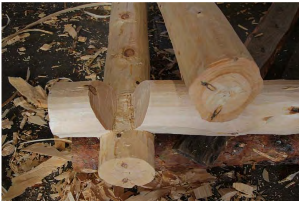
Enkel finndals laft fra 2019 med referanse i tømmer fra før år 1009. Foto Per S.
