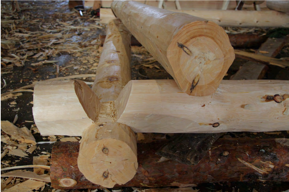
Figur 7 Fra arbeidet med å rekonstruere tømringa i knuten i bygning 4 fra Klemenskirkeutgravingen. Et enkelt findalslaft. Foto Per Steinar Josteinson Brevik.
