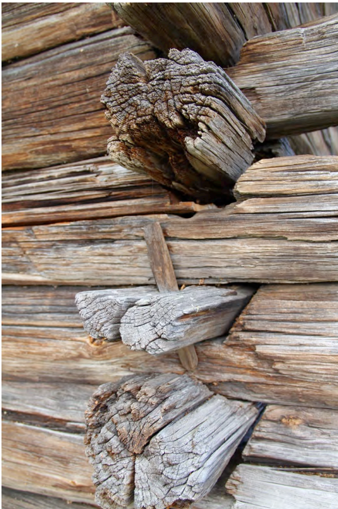
Figur 5 Rännknuter i et härbre fra middelalder i nærheten av Mora i Sverige. Knuten er i hovedsak uforandret i en periode på nesten 1000 år, fra omkring år 1000 til inn på 1800-tallet. Foto Per Steinar Josteinson Brevik
